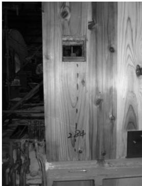
写真 1-4 引きボルト接合の例
