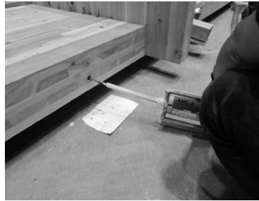
写真 1-2 GIR 接合の施工の様 子
