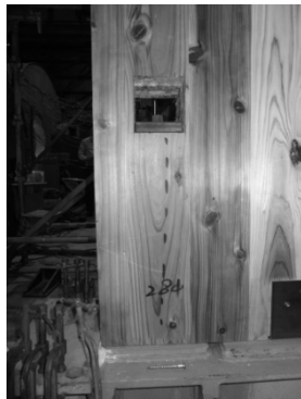
写真 1-4 引きボルト接合の例
