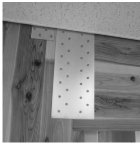
写真 1-1 鋼板添え板ビス 接合の例（せん断金物）
