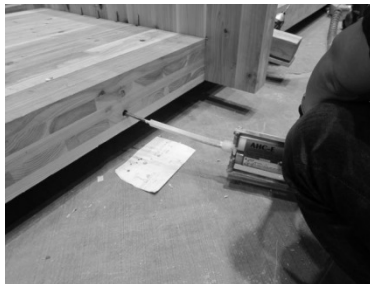
写真 1-2 GIR 接合の施工の様 子
