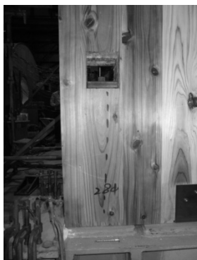
写真 1-4 引きボルト接合の例
