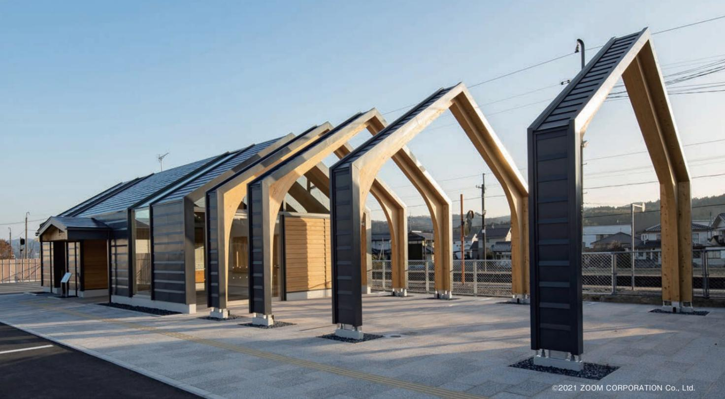
壁・屋根にCLTパネル工法を採用した平屋建ての鉄道駅舎です。
