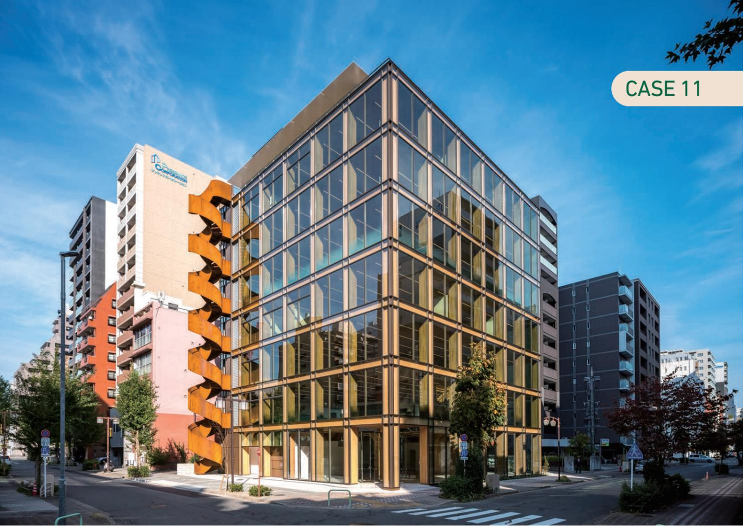
CLTをRC造の型枠として使い、CLTによりRC造を補強し、内装仕上げとしても使う、CLTとRCのハイブリッド構造のオフィスビルです。
