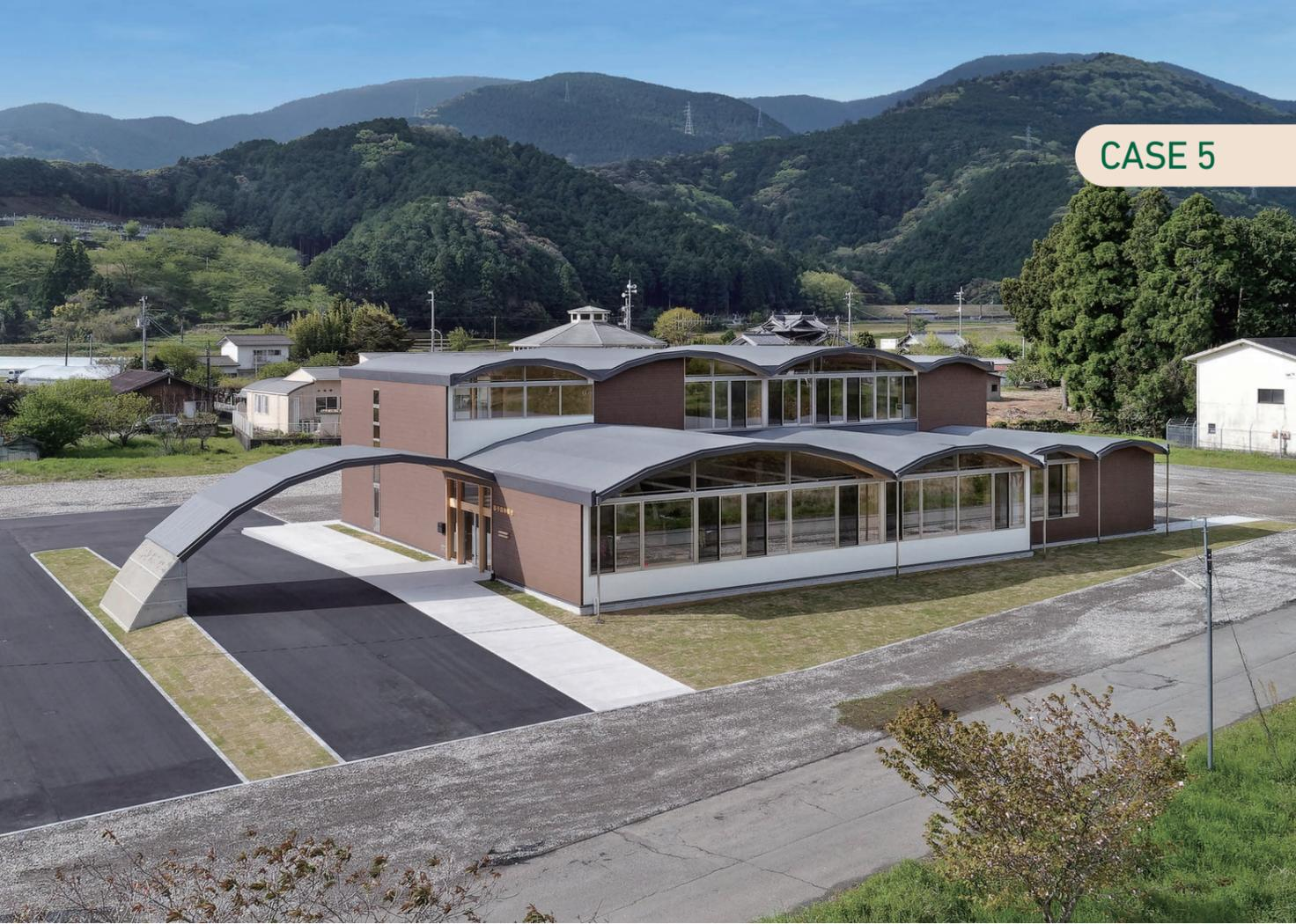
CLTパネルを屋根・壁・床に用いた2階建て事務所です。
