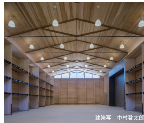
ミヨシ産業(倉庫棟) 構造：CLTパネル工法 階数：1 延べ面積：498㎡ ※詳細はP.26
