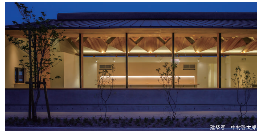
ミヨシ産業(事務所棟) 構造：木造軸組構法+CLT (屋根) 階数：1 延べ面積：157㎡
