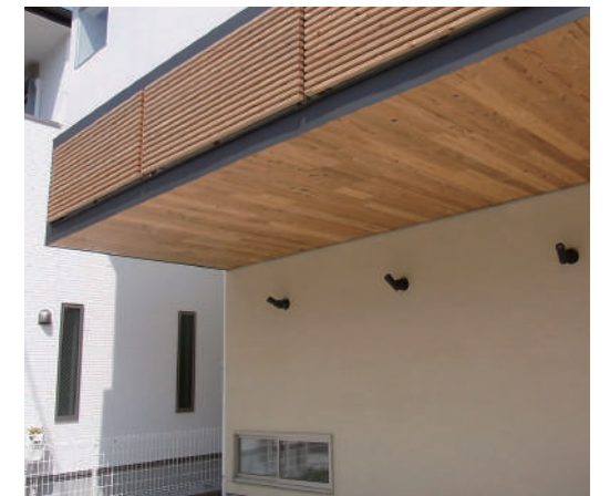
CLTはね出しによる庇
