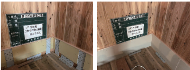
金物耐火被覆前
