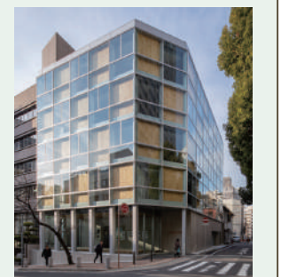
写真提供：(株)竹中工務店 協力：兵庫県都市木造建築支援協議会
