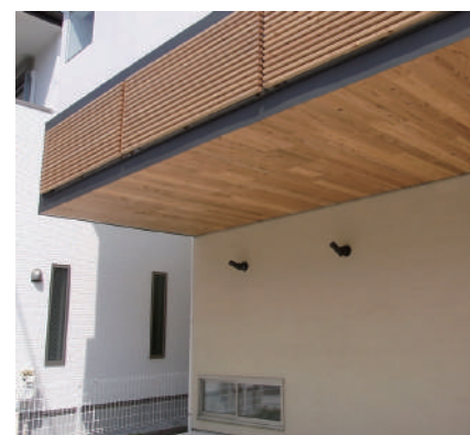
CLTによるはね出し部分
