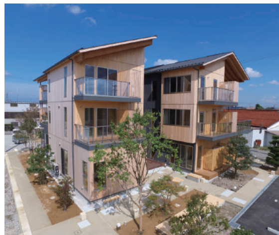
ティンバードテラス 構造：木造軸組構法+CLT (床・壁) 階数：3 延べ面積：779㎡ ※詳細はP.50
