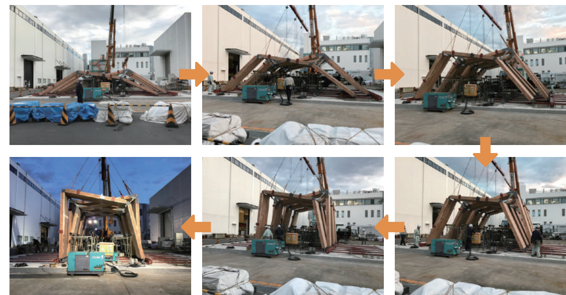
1/2モックアップによる施工実験
