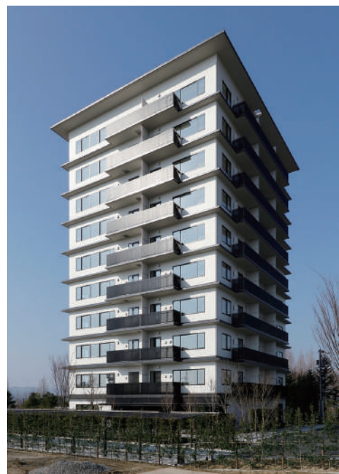
PARK WOOD 高森 構造：鉄骨造+CLT (床・壁) 階数：10 延べ面積：3,605㎡ ※詳細はP.86
