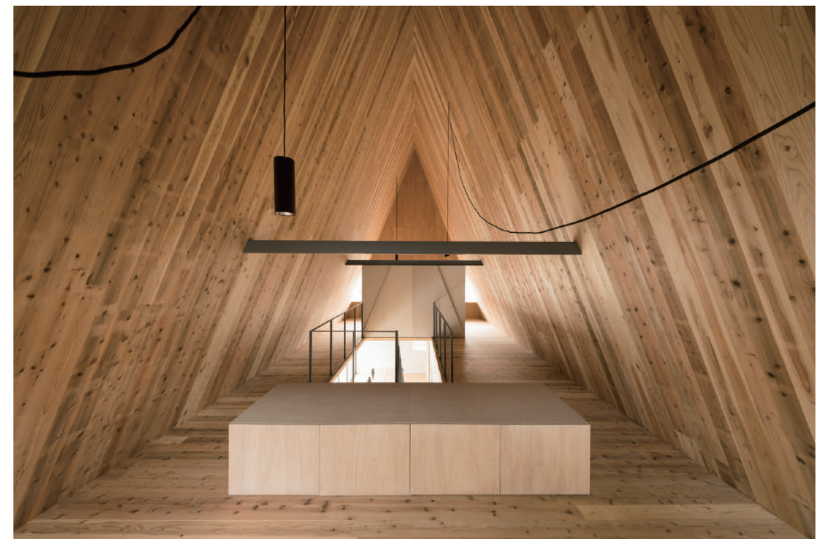
現しのCLTのトラス状構成による小屋裏空間
