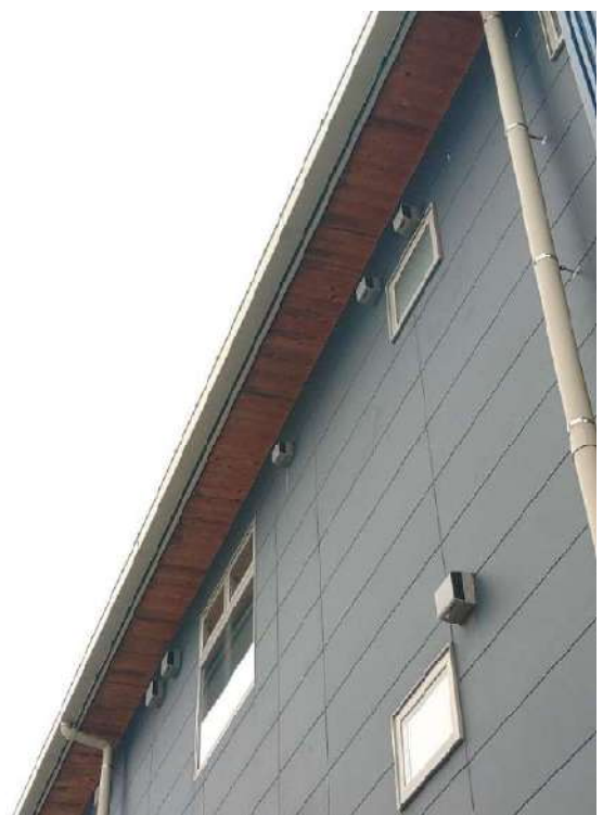
北側(建物裏側)軒天部 特に問題なし
