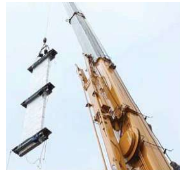
CLT + 鉄骨梁パネルの吊り上げ
