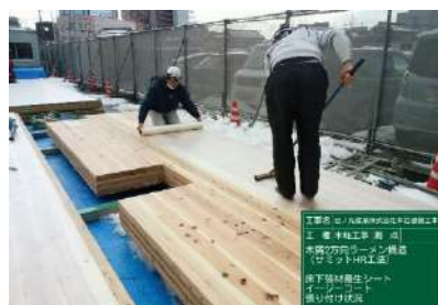
CLT床版への養生シート張り
