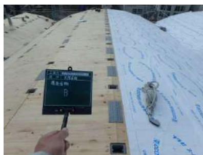
円筒屋根の CLT 施工状況
