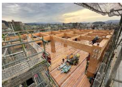
建て方の状況
