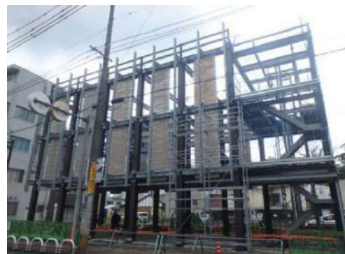
現場施工状況
