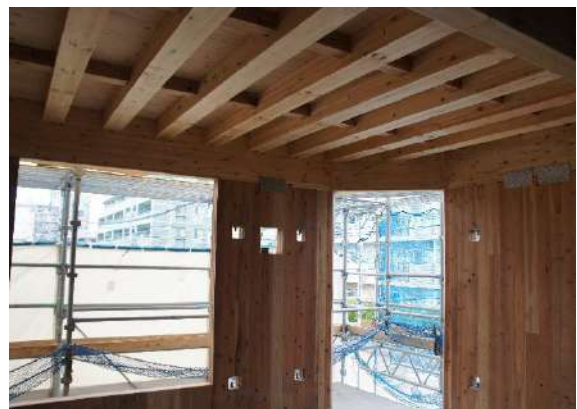
CLT パネル、軸組の施工状況
