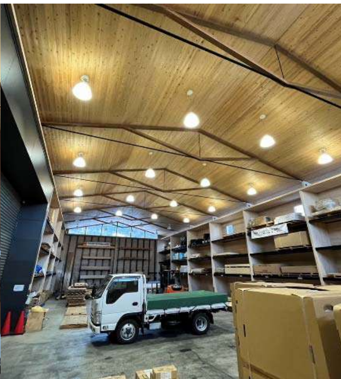
倉庫棟 内観写真
