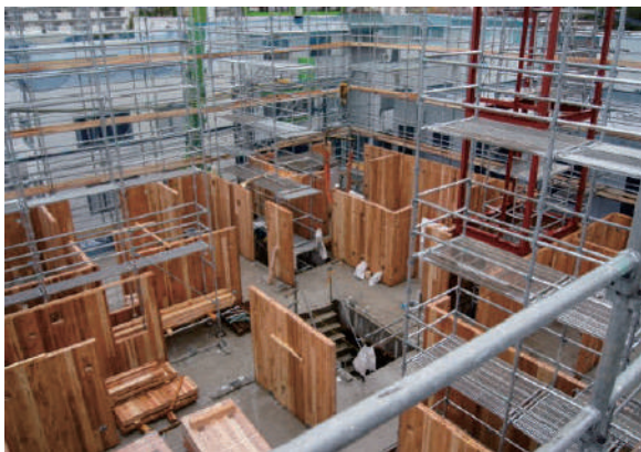
CLT パネルの建て方の状況
