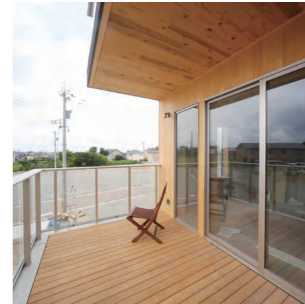
CLTはね出しによるテラス
