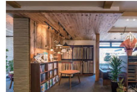
ライフデザイン・カバヤ 倉敷支店 構造：木造軸組構法+CLT(床・壁・天井) 階数：3 延べ面積：736㎡
