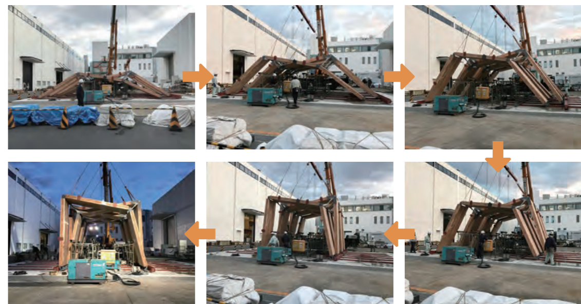
1/2モックアップによる施工実験
