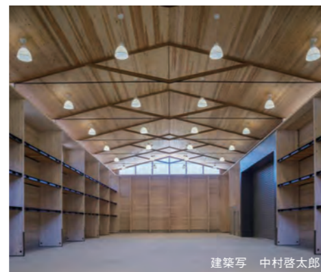
ミヨシ産業(倉庫棟) 構造：CLTパネル工法 階数：1 延べ面積：498㎡ ※詳細はP.26 建築写真 中村啓太郎
