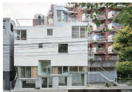
猿楽十方楼 構造：CLTパネル工法+RC造 階数：地上3階、地下1階 延べ面積：180㎡
