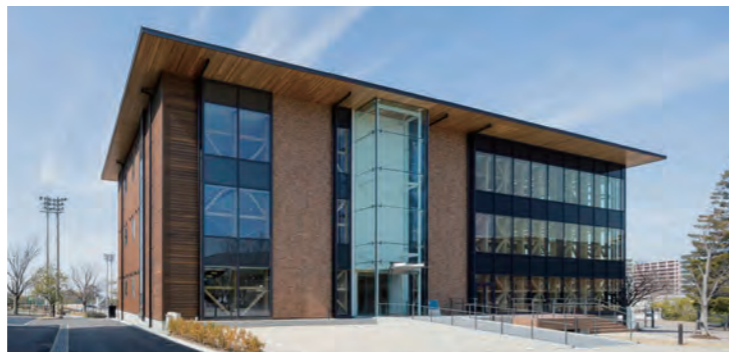
桃山学院エレノア館 構造：木造軸組工法 +CLT(床・屋根) 階数：3 延べ面積：2,220㎡
