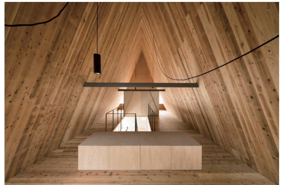
現しのCLTのトラス状構成による小屋裏空間
