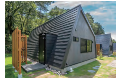
エンゼルフォレスト中伊豆 構造：木造軸組構法+CLT(屋根) 階数：1 延べ面積：316㎡
