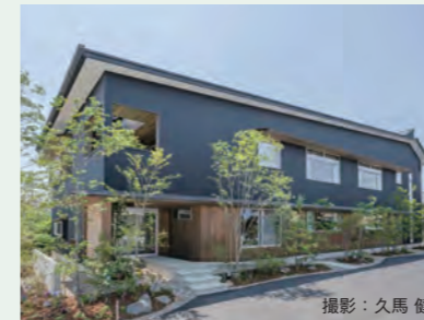
山陽建設CLT&ZEBオフィスビル
