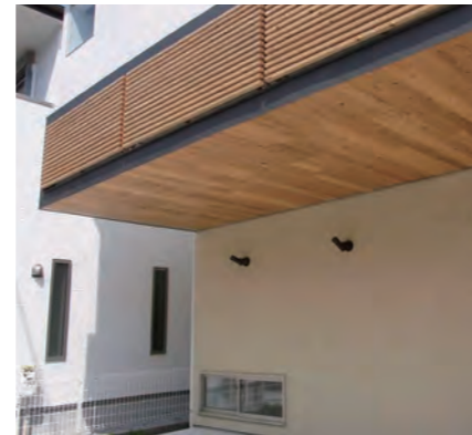
CLTによるはね出し部分
