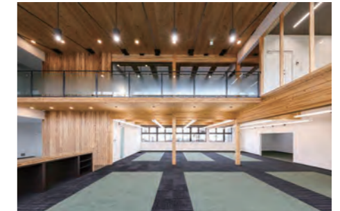
シンコール社屋 構造：CLTパネル工法 階数：2 延べ面積：755㎡
