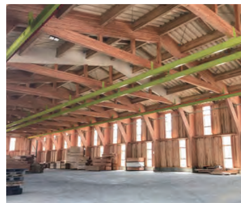
㈱中東 構造用集成材製造工場 構造：集成材等建築物+CLT(壁・梁) 階数：1 延べ面積：1,994㎡
