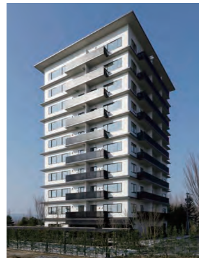
PARK WOOD 高森 構造：鉄骨造+CLT(床・壁) 階数：10 延べ面積：3,605㎡ ※詳細はP.98
