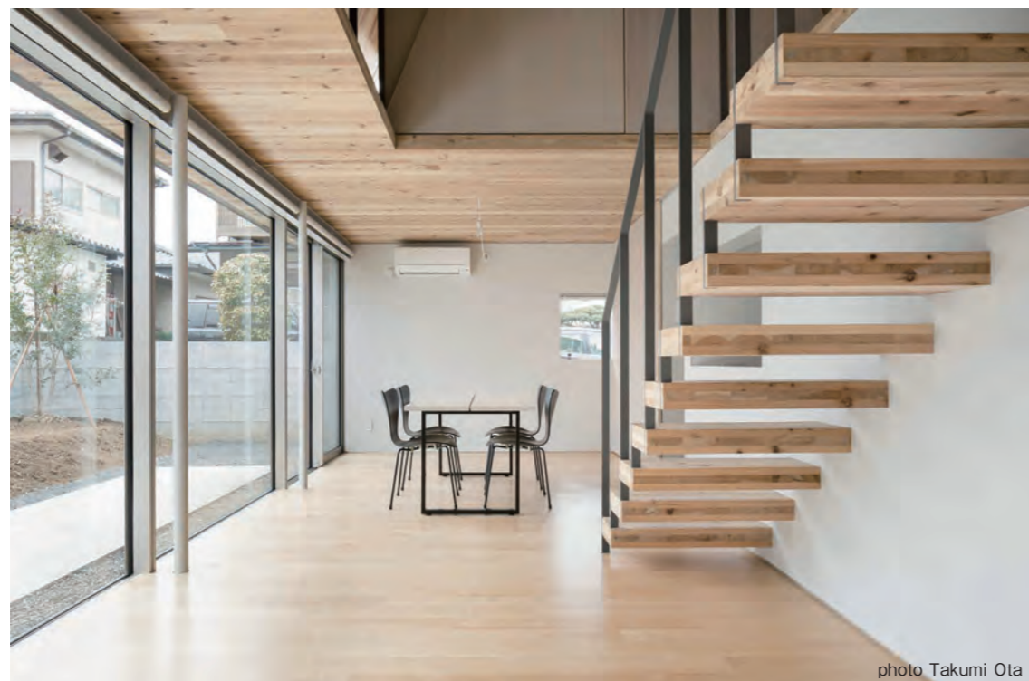
吹き抜け部分と段板にCLTを使用した階段
