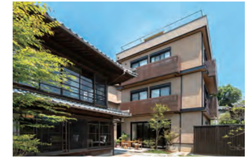
富士屋ホテル 構造：CLTパネル工法 階数：3 延べ面積：825㎡
