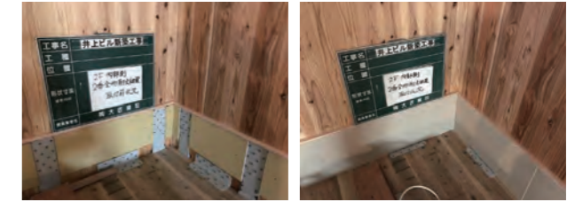
金物耐火被覆前
