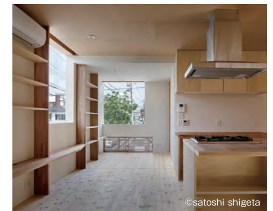
2階居住部分。CLTはね出しによって必要床面積を確保した
