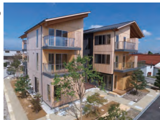
ティンバードテラス 構造：木造軸組構法+CLT(床・壁) 階数：3 延べ面積：779㎡ ※詳細はP.58
