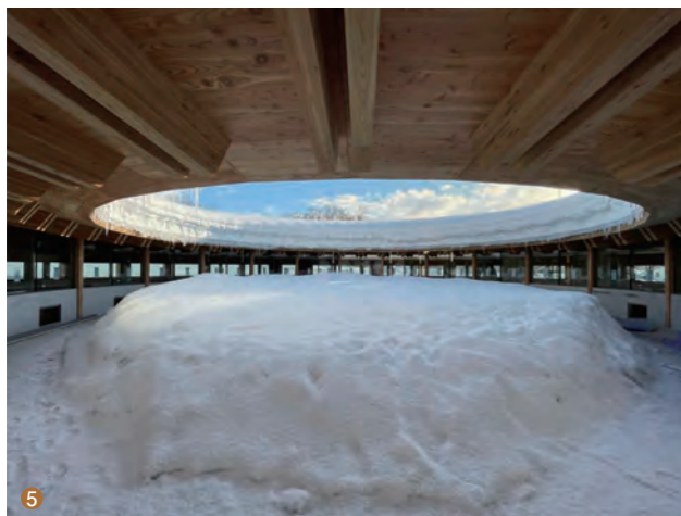
①② 集成材の柱梁及びCLTの外壁、屋根パネルの施工。 ③ 外壁側元元のRC壁の配筋状況。 ④⑤⑥ 中庭は、水を張れば水盤となり、冬季の雪だめスペースにもなる。
