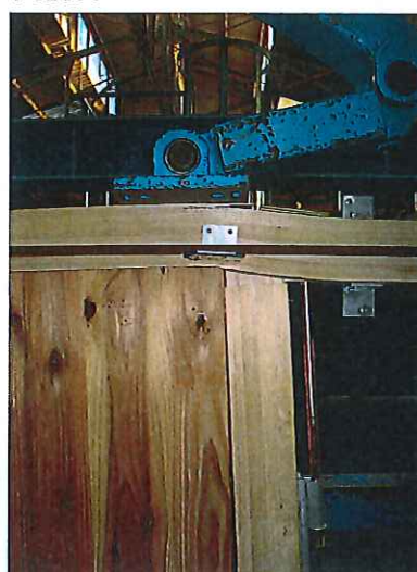
写真-14 破壊状況 番号：4 最大荷重：17.8kN
