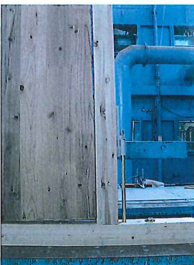
写真-11 破損状況 番号：3 最大荷重：20.7kN ・ねじの抜けによるパ ネルの浮き上がり ・座金の土台へのめり 込み
