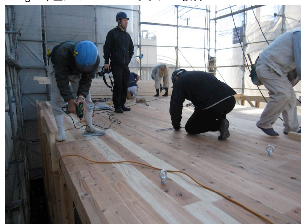
fig3:軸組にビス接合
