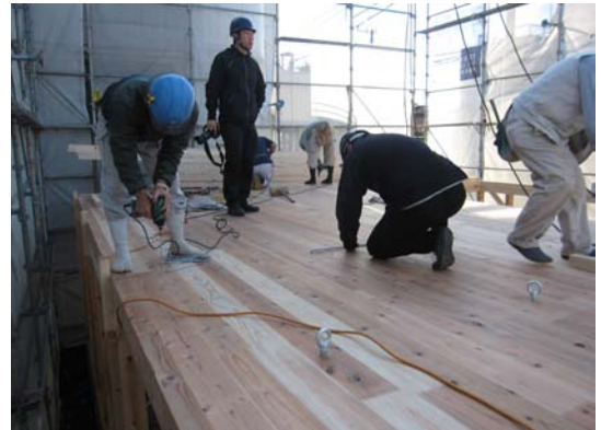
fig. 5 工程 2 (c)軸組への接合作業
