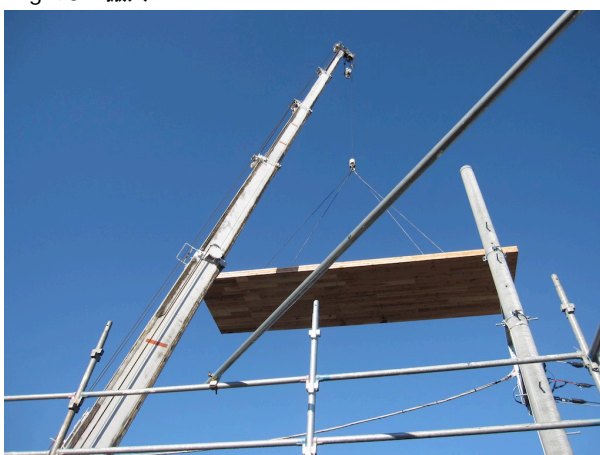
fig3:レッカーにてCLT吊り込み
