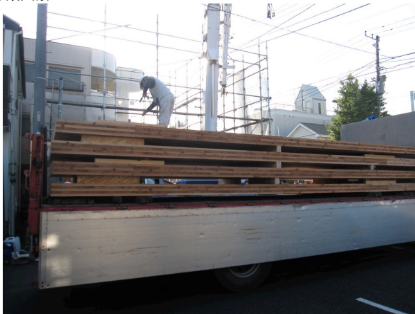
fig1:CLT搬入
