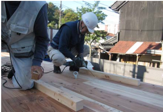
fig. 4 工程 2 (a)-(b)車上での作業風景
