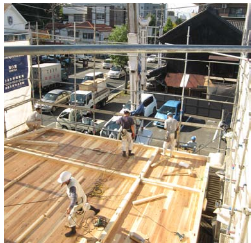
fig. 6 地伏梁敷設作業
