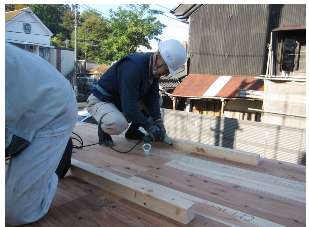
fig2:車上にてCLT01-02ななめビス接合
