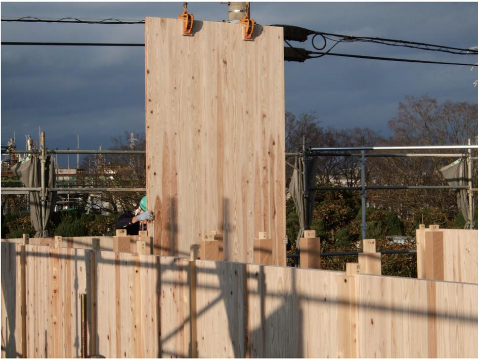
Fig. パネルのつり込み
