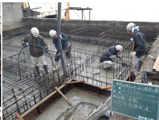
配筋 耐圧版打設
