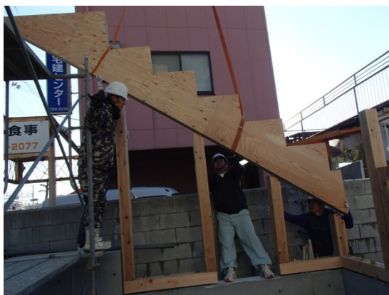
LVL 建方⑤通り
