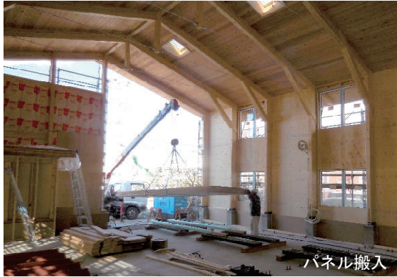
パネル搬入・重機建て逃げ用の工事開口
