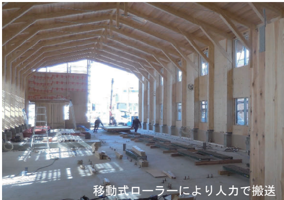
パネル搬入・重機建て逃げ用の工事開口
