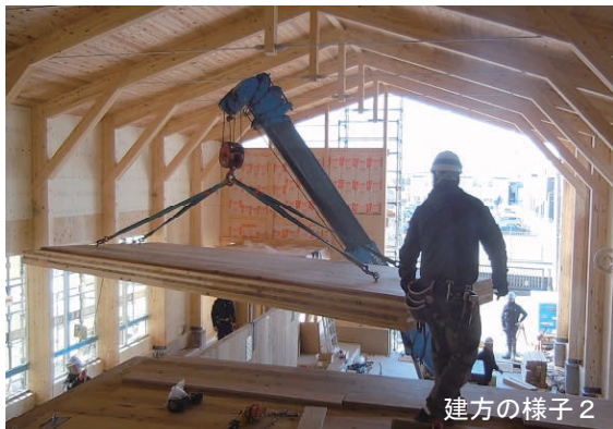
床パネル吊上げ用の金具
