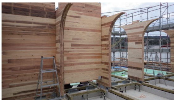
図 10.4 壁パネル架設状況
