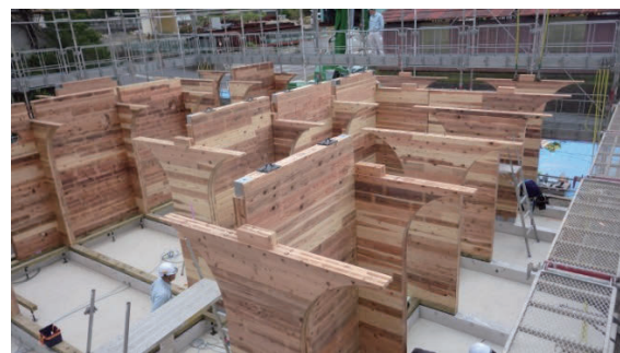
図 10.5 壁パネル架設完了時
