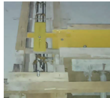
図 10.3 本工事での固定状況
