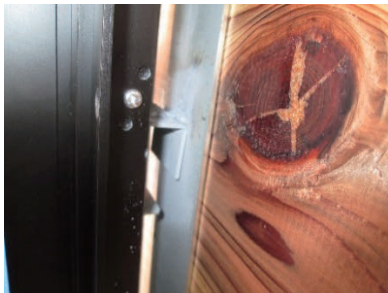
図 10.8 サッシ枠固定方法
