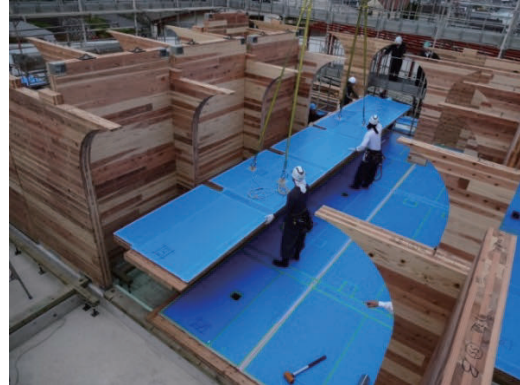
図 10.7 床パネル架設状況
