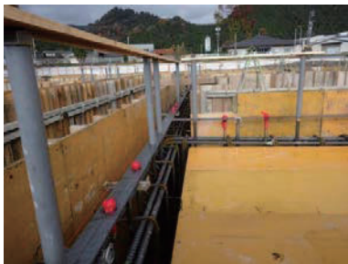
図 10.1 アンカーボルト固定事例
