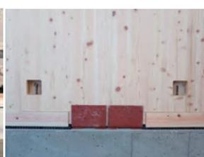
CLT パネルどうしの接合方法は、実加工された小口を重ね合わせ、200ピッチにラグスクリュービスで連結している。構造計算上はこの連結は必要とされていないが、表での仕上げの場合、パネルどうしの連結は施工時のパネルの自立、狂いの調整に必要であり、将来的な収縮に対しても有効であるためにそのように行なった。
