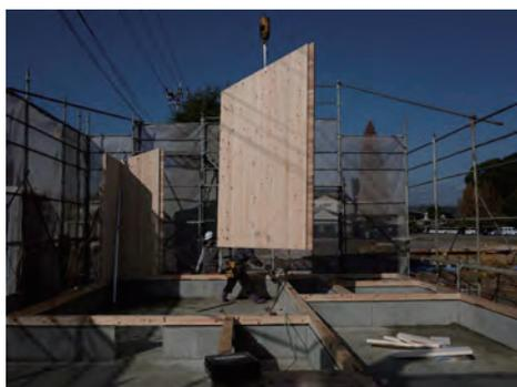
CLT 壁パネルは表での仕上げ面を下面し積み重ね、運搬時に汚れ等が付かぬよう養生し輸送を行なった。CLT 壁パネルの吊り込み設置に関して、工場でパネル上部 20φ の穴を開け、現場でその穴にスリングを通し、吊り込みを行なった、また今回新たな試みとして、欧州製の吊り込みジグを使い、パネル小口面に 40φ の穴を工場で開け、そこにその治具を挿入し吊り込みを行なった。ただし、この治具の特性上、垂直に荷重がかかることによりジグが開きその摩擦でパネルを吊り込む機構になっているために CLT 壁パネルの上部が斜めにカットされているパネルには使
