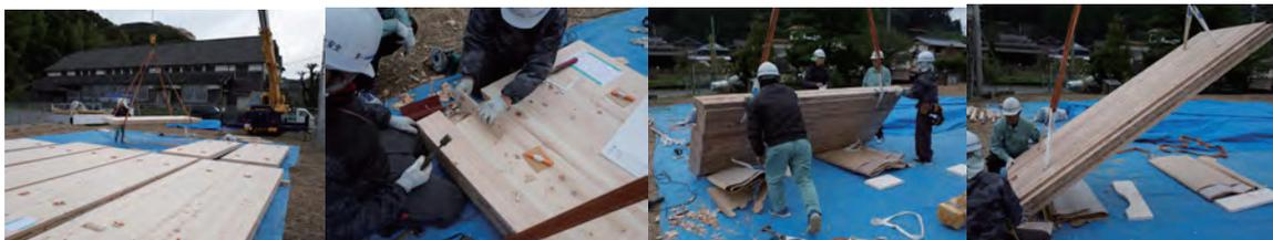
CLT 屋根パネルと CLT 壁パネルの接合に関しては、L 型金物と 20M のボルトで接合するため、壁パネルと同じく表面の精度を出すためボルト貫通の穴あけに関しては、CLT 屋根パネル
