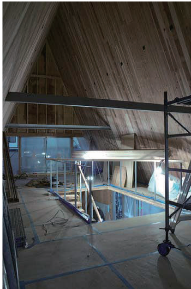
風によるたわみを抑制する鉄骨のつっぱり棒
