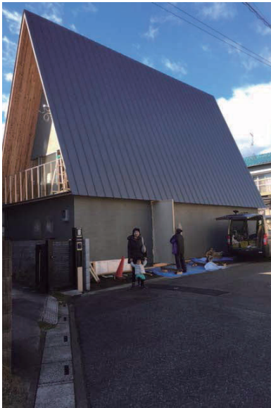
外部足場を外れた上場
