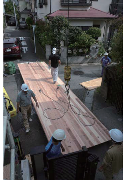
CLT 板のレッカーでの吊り上げ
