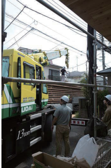
岡山の工場より搬入された屋根 CLT 板
