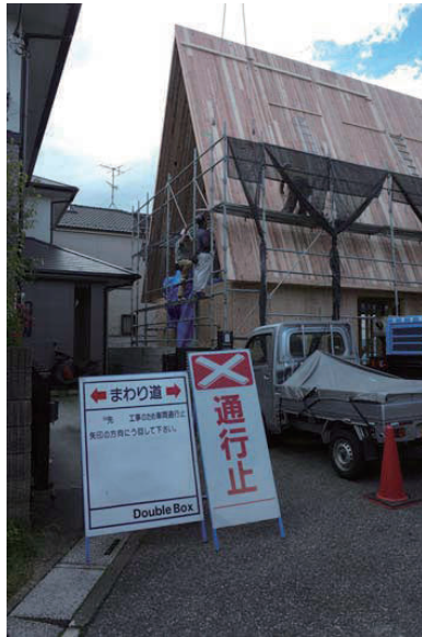
、そして両側の建方が完了
