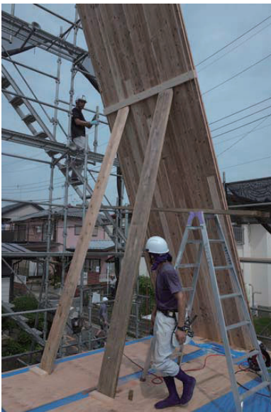
仮設材で片側のみの屋根 CLT 板を支える
