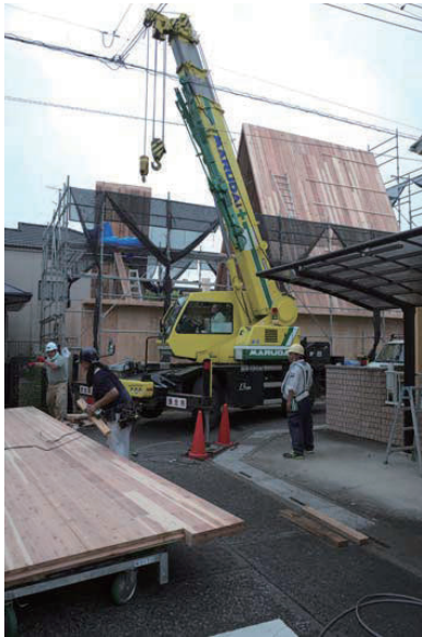
1日目の建方を中断し荷卸しに専念
