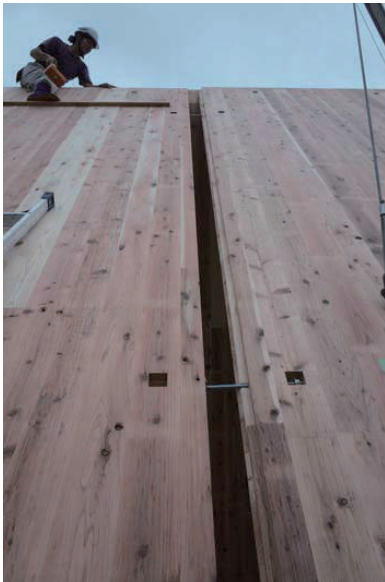
位置を微調整しながら中締めボルトで仮固定
