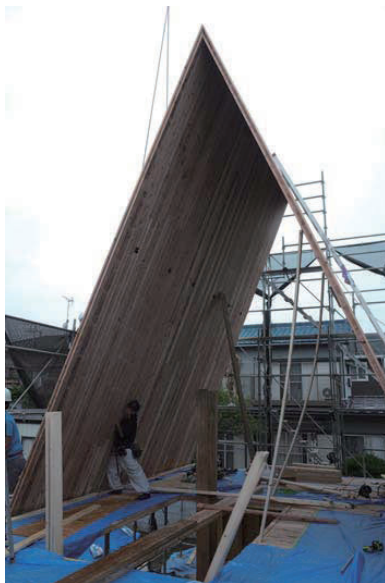
たわみを調整しながらサネに押し込む
