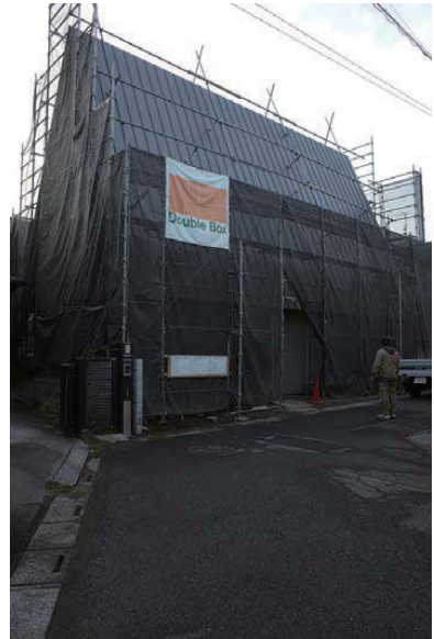
屋根の鋼板葺きの施工状況
