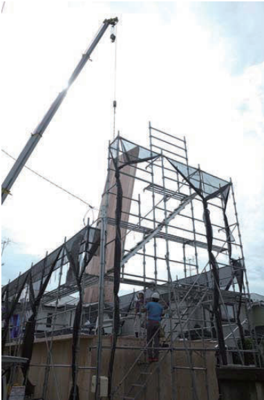
電線の位置等を事前調査しての吊り上げ作業
