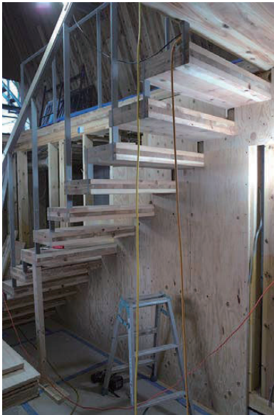
CLT 板を活用した階段の施工状況
