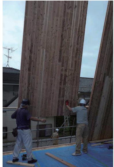
板の反りによりサネに入りにくい板もある
