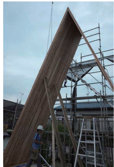
棟部分を中締ボルトで仮締め
