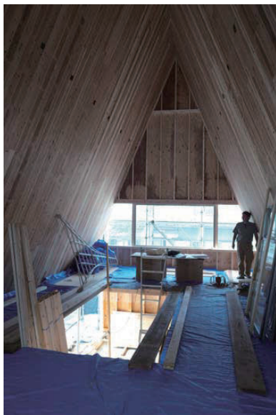
軸組による妻壁の施工状況
