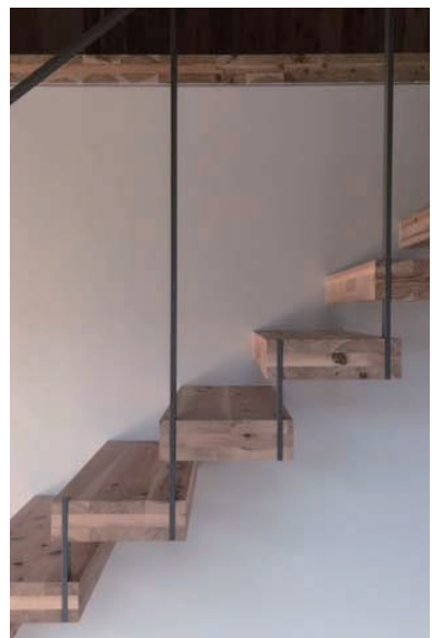
CLT 板を活用した階段の詳細
