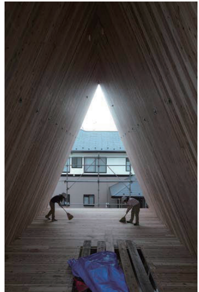
床と屋根の CLT 板の構成が完結
