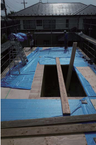
床 CLT 板の敷設完了時
