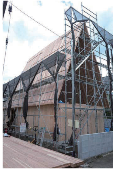
妻側は棟の固定のために足場を高くしている
