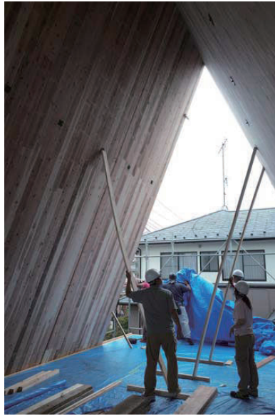
次の CLT 板がスムーズに入るよう反りを調整
