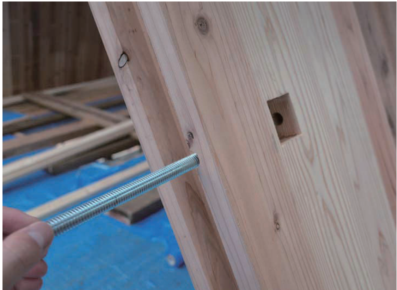
CLT板同士を仮固定するための中締めボルト(工場で開口と穴を事前加工)
