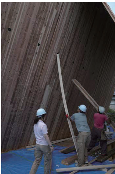
吊り金具を利用しつつかえ板を設置し、
