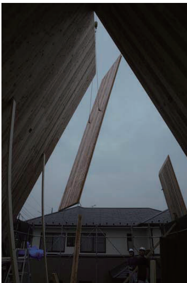
荷積み誤順序によりCLT板の仮置きが発生
