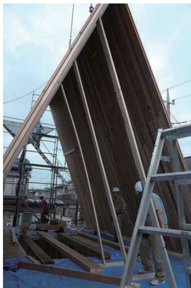
CLT板の反りを修正
