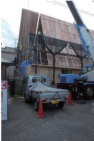
東側の最後の CLT 板の片側、
