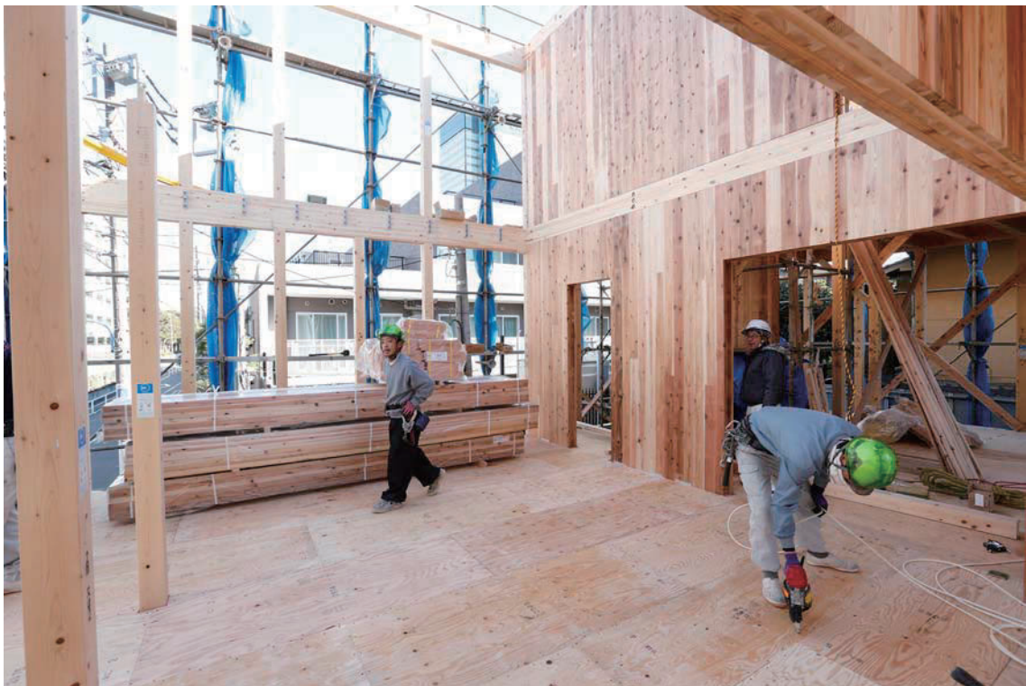
写真4 CLT建方時の様子3日目
