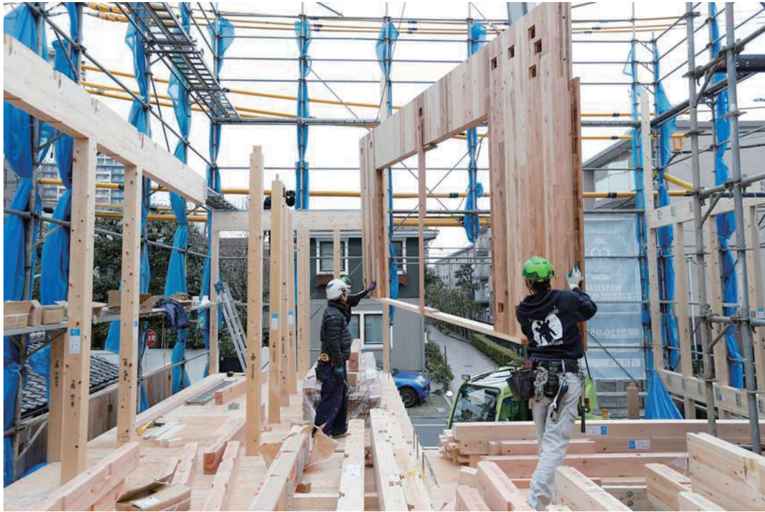
写真2 CLT建方時の様子2日目
