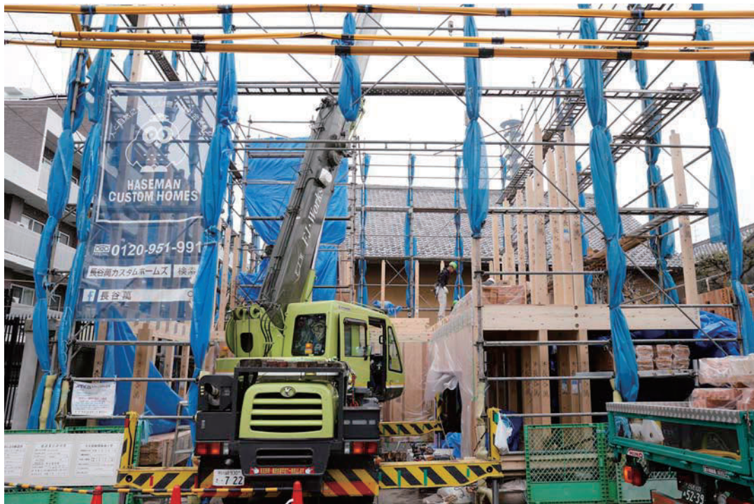
写真1 CLT建方時の様子1
