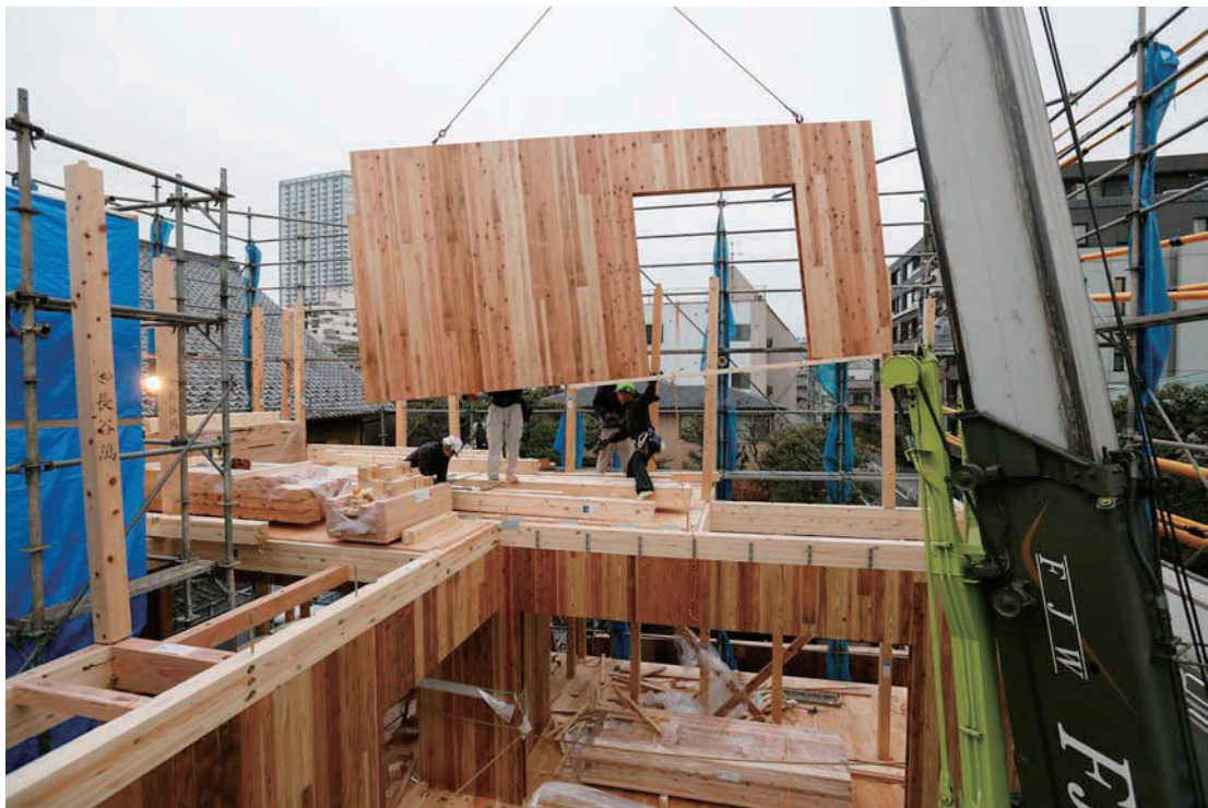
写真3 CLT建方時の様子2日目-2
