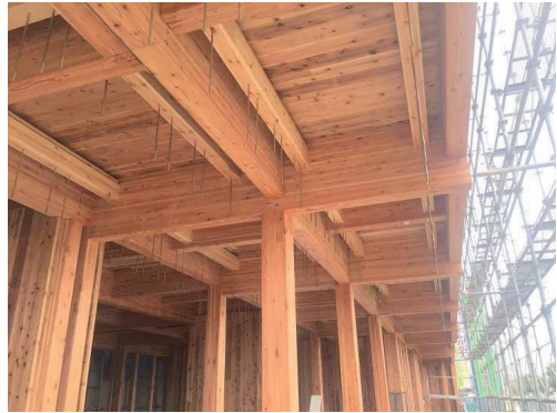
造作用化粧 CLT パネル吊りボルト
