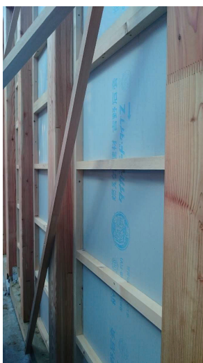
60 分準耐火用 PB 先行施工状況
