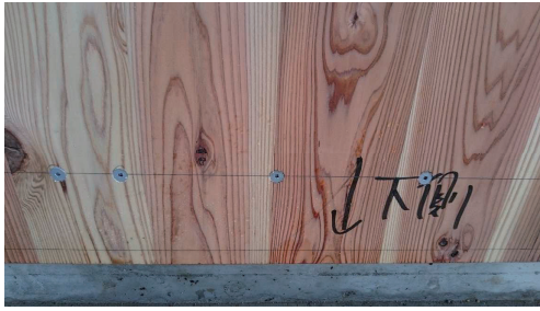
木木ビス（タッピンねじ）施工状況
