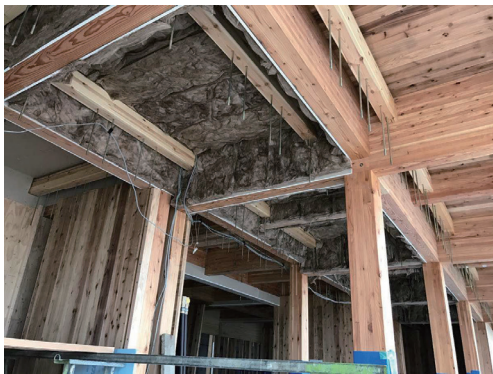
60 分準耐火被覆施工状況
