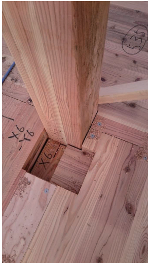
柱脚金物設置の為、 水平構面 CLT へ先行加工
