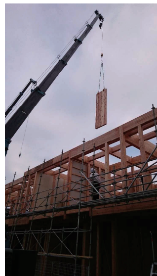
CLT 吊り込み状況 軸組の為、 横架材間に下ろす必要有
