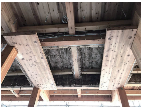
造作用化粧 CLT パネル施工状況（屋内）
