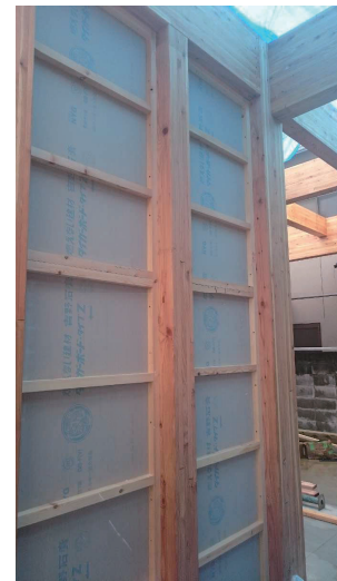
60 分準耐火による被覆施工 ※CLT 鉛直材化粧現し
