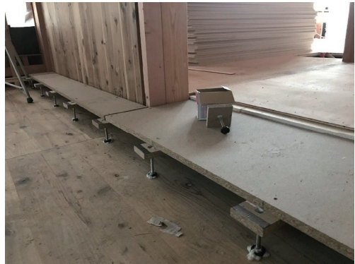
2F 乾式二重床施工状況
