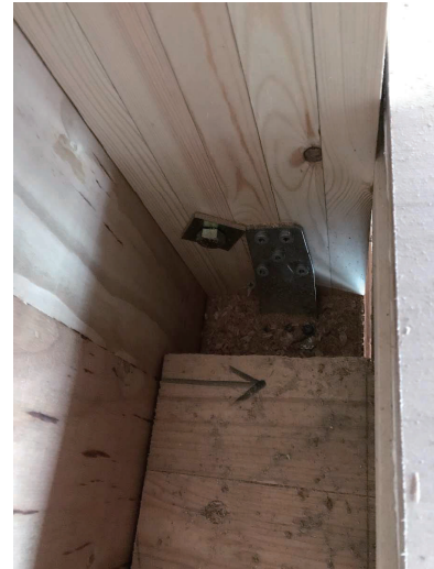
2F 床水平構面 CLT へ 柱脚金物取付用先行加工
