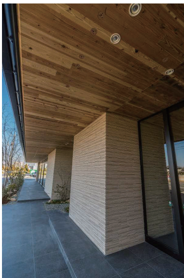
完成状況（屋外）
