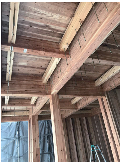
上棟後 水平構面 CLT 横架材等施工状況
