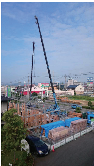
上棟の様子 レッカー×2台
