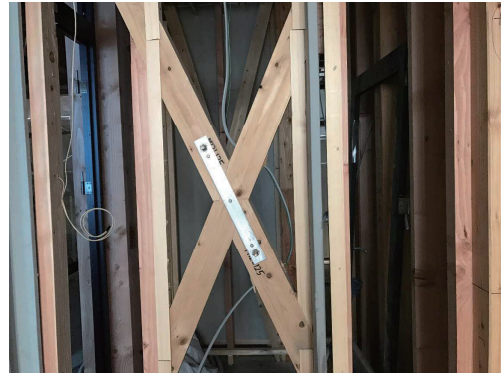
スジカイ施工状況
