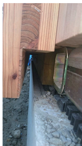
CLT 壁鉛直材設置用 補助金物との取合部 加工状況
