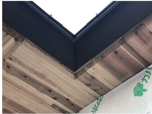
軒先 CLT 納まり状況
