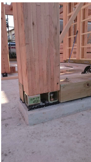
1F 柱脚金物 唐松集成平角柱
