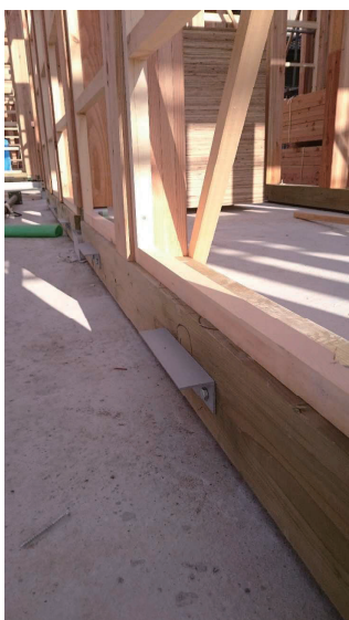
CLT 壁鉛直材 設置の為の自重受金物 (写真 a)
