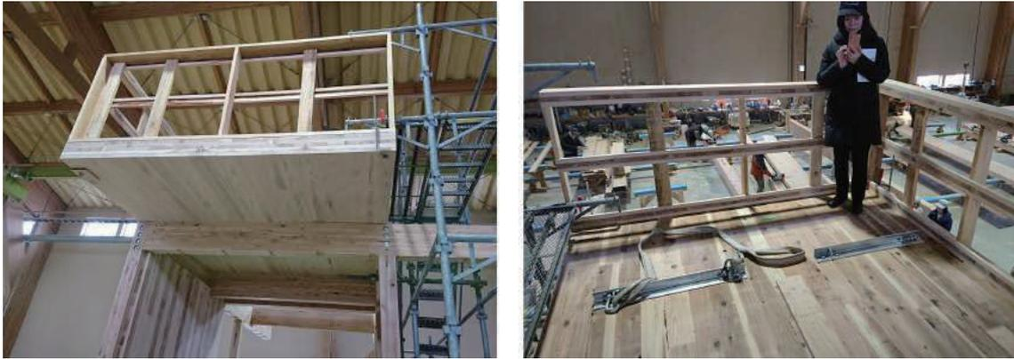
テラスにおけるはね出し床については、上面に根太組、構造用合板 2 枚貼りによって勾配を設け、FRP 防水を施工する予定である。(図面参照)
