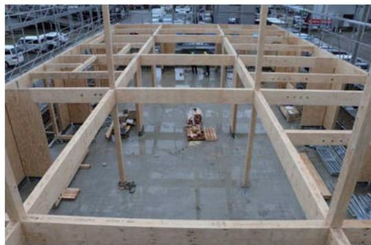
2階床梁組立後、高さ、位置の確認を行った。この時点では、LVL パネル柱が傾いている事が目視でも分かる。
