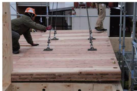
CLT の版を吊り上げるため CLT に製作金物をビスで固定した。CLT を現しに用いる場合はボルト孔が開かない今回の方法は有効である。
