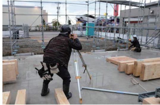
アンカーボルトの配置により1階LVLパネル柱の位置が決定するため、アンカーボルト位置の精度が要求される。事前にアンカープレートを活用し位置決めを行い、高さはレベルにて確認を行った。
