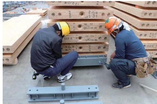
1階LVLパネル柱の柱脚鉄骨コネクタは現場で取り付けを行った。プレカット工場で挿入したLSBに対して、鉄骨下フランジからキャップスクリューを留めつけた。柱脚鉄骨からせん断キーが出ている事により、位置決めがスムーズに行われ、現場施工でも対応が可能であった。
