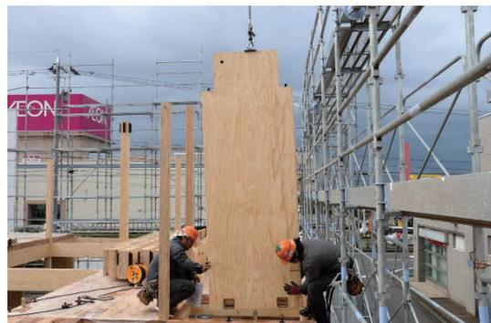
④ 2階 B種 LVL 耐力壁柱建方
