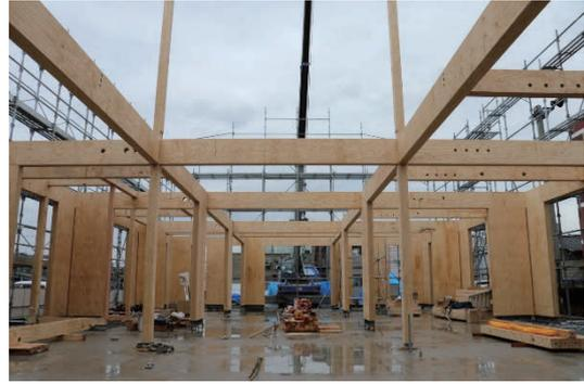
② 1階 B種 LVL 耐力壁柱 梁つなぎ完了
