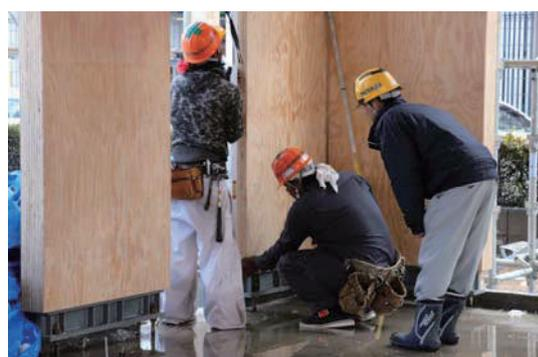
CLT 設置後、さや管、SNR ボルトを挿入。
