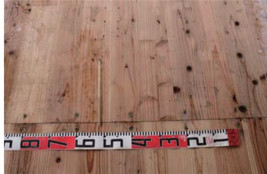
CLT と梁との接合には  $\phi 8 \text{ mm}$  L=280mm のビスを用いた。ビスはインパクトドライバーでは施工困難のため、ドリルドライバーを用いた。推奨は低速ドリルドライバーである。
