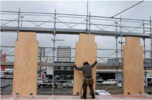
1階 LVL パネル柱頂部に配置したせん断キーが、2階の LVL パネル柱の位置決めとなった。
