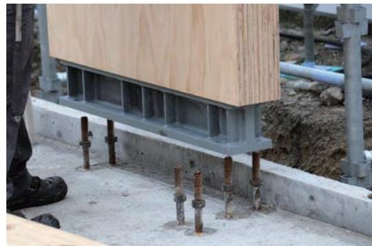
LVLパネル頂部に埋め込まれているLSBの雌ネジ部分にアイボルトを埋め込み、クレーンで吊る事で、パネル設置がスムーズに行われた。
