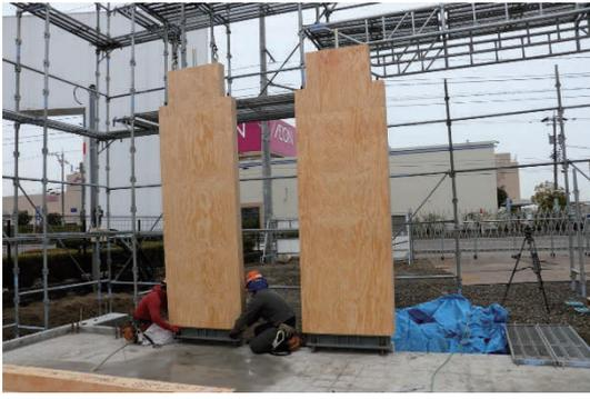
① 1階 B種 LVL 耐力壁柱建方
