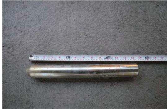
LVL パネル柱の頂部には φ50 mm L=400mm のせん断キーを入れている。
