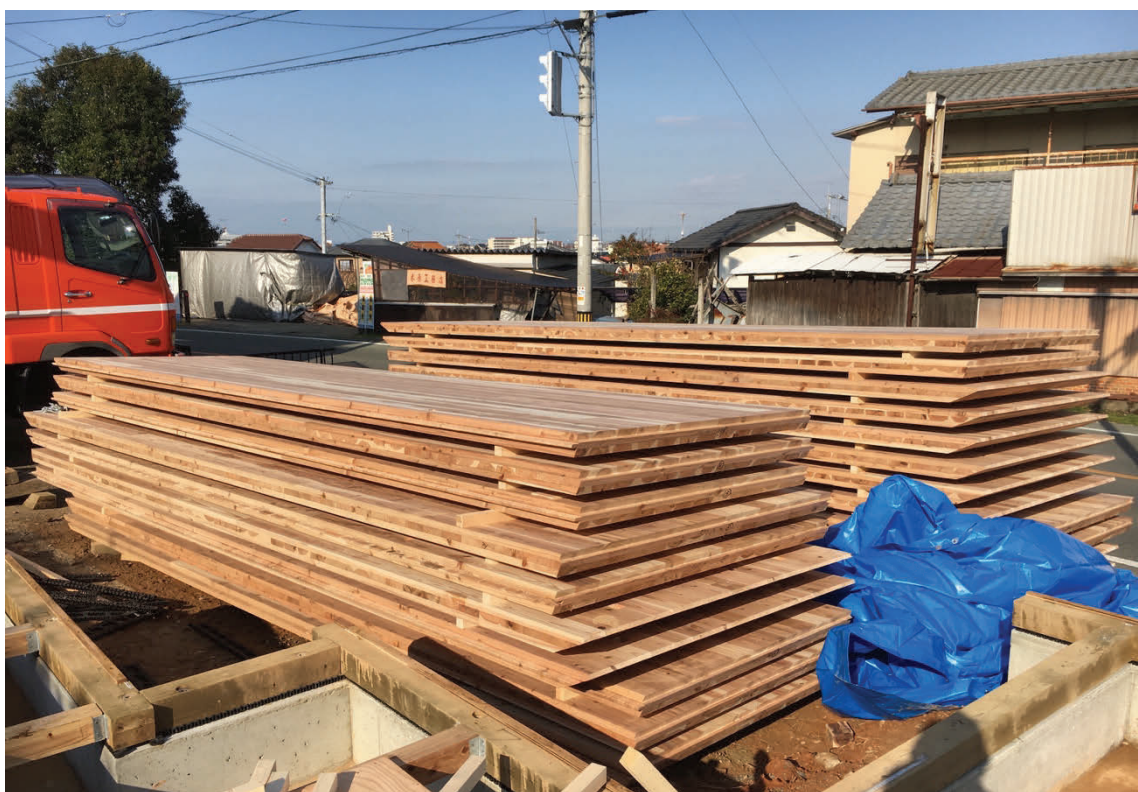
写真 1 CLT パネルは、敷地に搬入後しばらく野積みになってしまったが、シートでの養生により特に問題は起こらなかった
