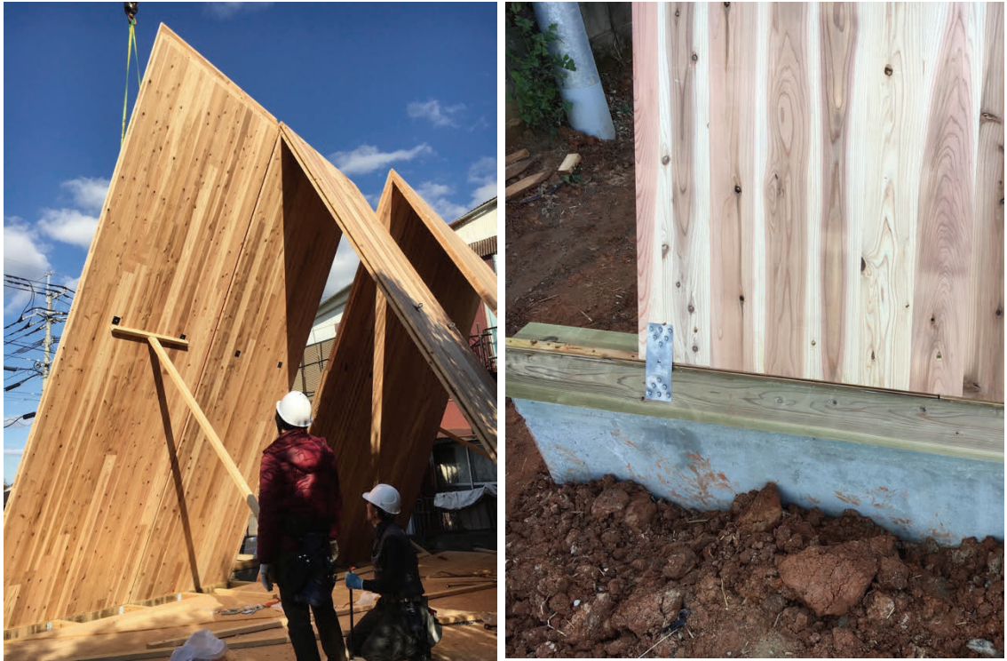
写真 4 CLT パネルの小口に実加工をし、パネル同士を嵌め込む。クレーンやトンボで調整しながら、小口からハンマーで叩き実を嵌め込んでいった。相欠き等のより簡易な方法への改善余地がある。土台には銅・第四アンモニウム化合物系木材保存剤を加圧注入しているため、亜鉛めっき製品であるアンカーボルトや長ビスの腐食が懸念される。接合部の耐力には余裕があり、余程の腐食が発生しない限り問題とはならないと考えることもできるが、定期的にビス等の状況を確認していくつもりである。
