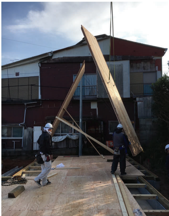
写真 3 建て方はクレーンから一番遠いユニットから開始。片側をトンボ状の支えで仮固定し、もう一枚をそれに立てかけるように建て込む。慣れると 3 人でスムーズに建て方が進んだ
