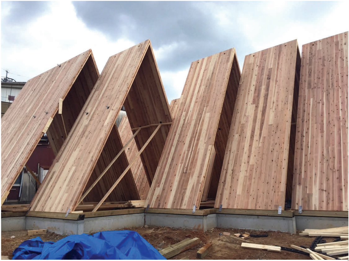
写真 6 パネル同士の接合がないユニットはスムーズに建て方が進んだ
