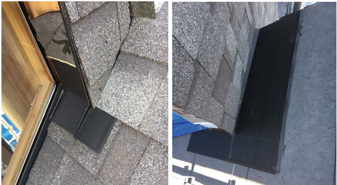
写真 5 ユニットの取り合い部分では、ルーフィングの上に一体的な捨て板金を重ねる。
