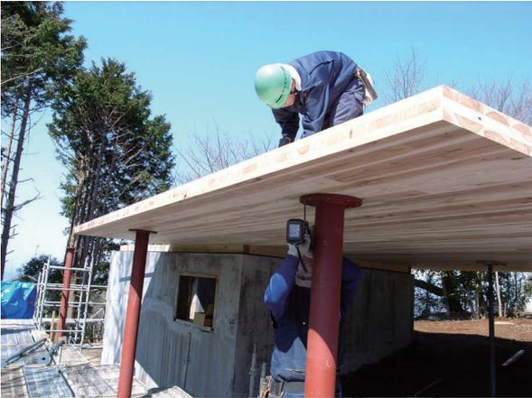
鉄骨柱頭のビス止めおよび上面への上層位置の野書き
