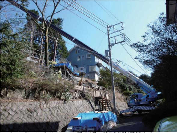
25t レッカーによる CLT の吊上げ。前面道路通行止め
