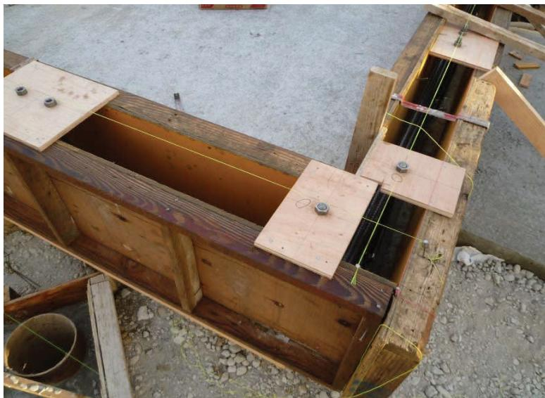
柱脚金物アンカーボルトは、型板固定にてコンクリート打設時のズレを無くした。アンカーボルト位置は誤差 $\pm 2\text{ mm}$ に押さえ、建て方時のズレ防止を図った
