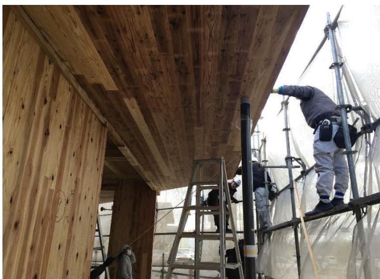
接合するだけで無く、鉄骨支柱垂直を保っての庇設置はプレカット精度と支柱建て精度がミリ単位の施工精度が要求された
