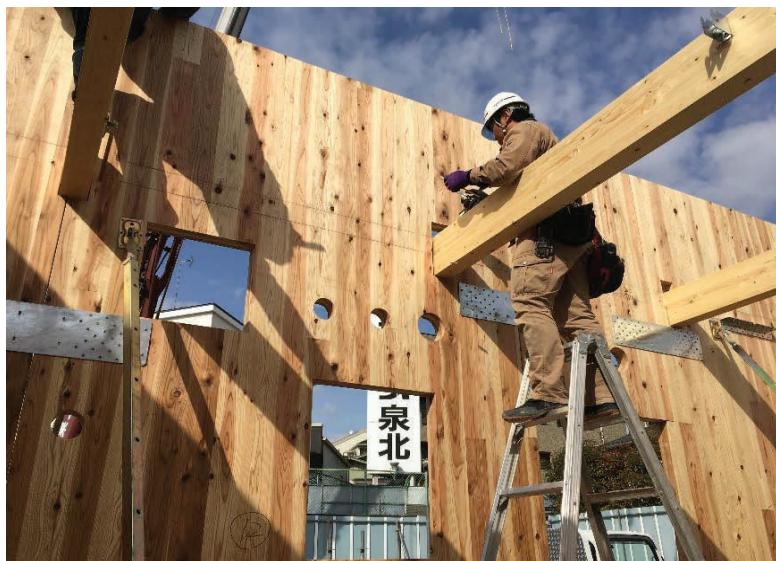
壁面に梁材差し込み後金物固定
