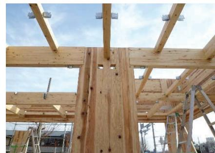
CLTに取付可能な既成金物が無いため、CLT－集成材はボルト接合。集成材－集成材は既成金物接合となった。
