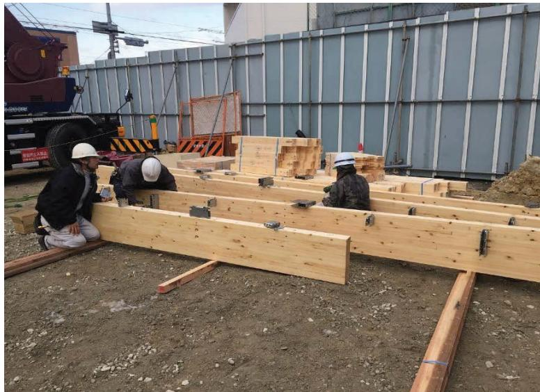
小屋組材にも、金物先付けで施工効率化を図る
