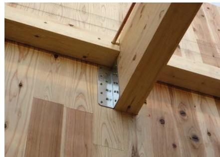
告示要求耐力により、満たすための金物過多になった（LST金物は両側設置）
