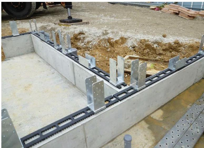
通気パッキン設置後、柱脚金物設置。アンカー施工精度により、不備無く迅速に金物設置が出来た
