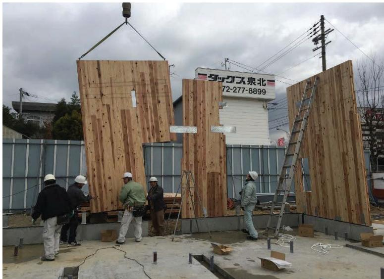
先付け後、建て方開始。CLT柱脚穴に対し、ズレなく設置が完了した
