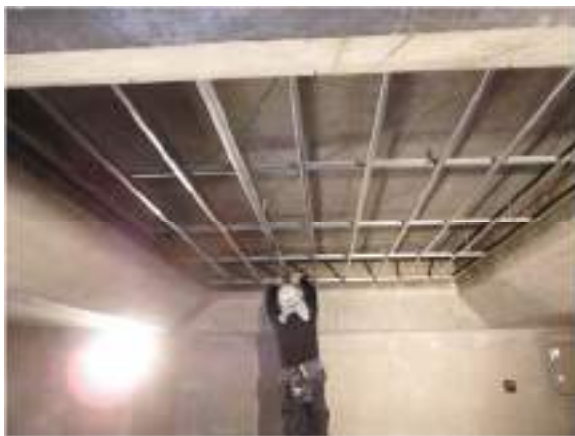
写真 3.2.2 天井下地施工状況
