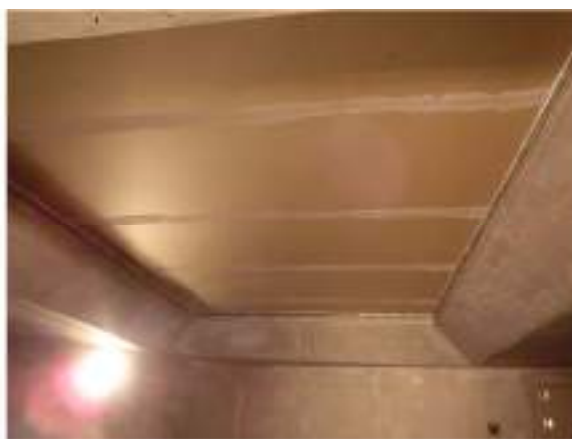
写真 3.2.5 試験体完成状況
