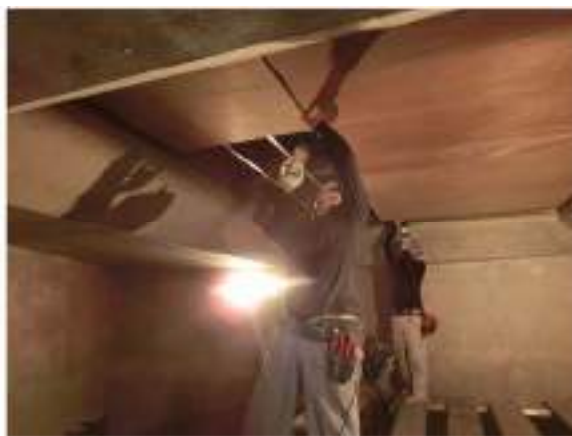
写真 3.2.3 積層制振パネル施工状況
