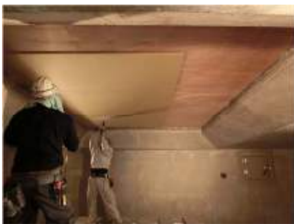
写真 3.2.4 石膏ボード施工状況
