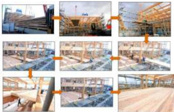
運搬トラックから直接 CLT 敷き込み作業を実施する。1フロア（計：CLT 9 枚）の敷き込みは約半日で完了する。
