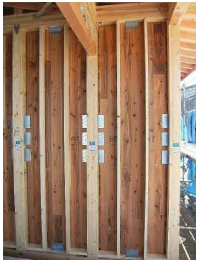
4. CLTパネル取付完了
