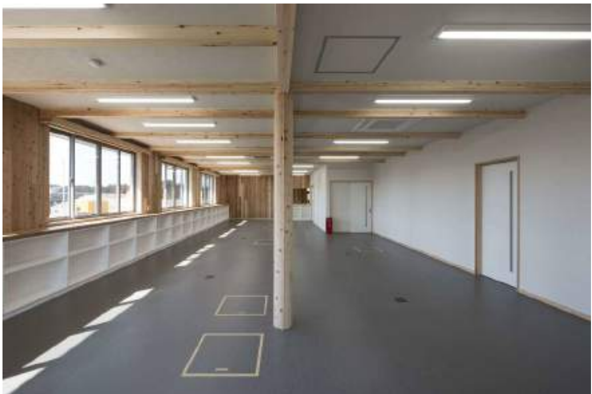
(事務室) 外壁面・一部間仕切(奥) スギCLT
