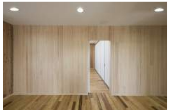
完成内観 ヒノキ・スギ・ヒノキ CLT(非構造)
