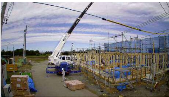
5. 建方 (CLTパネルは仮置き)
