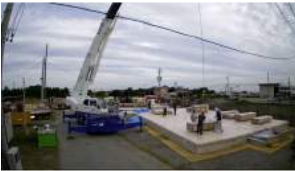
3. CLTパネル・軸組材搬入
