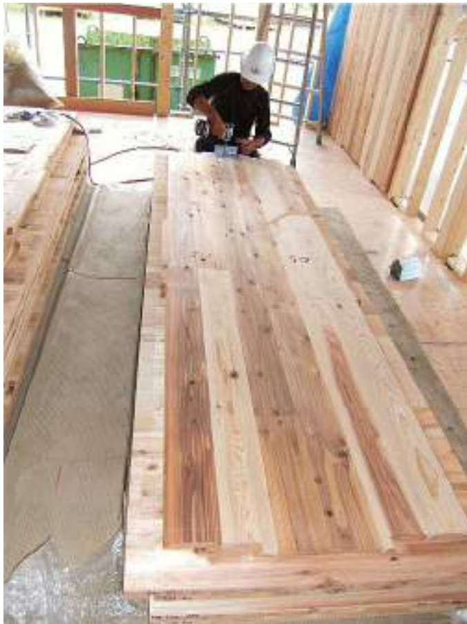
1. パネル取付前
