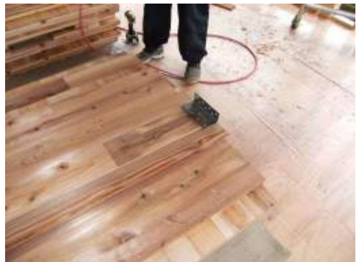
パネルに先行して留めつけた状況
