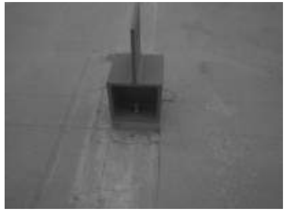
写真6 柱脚金物
