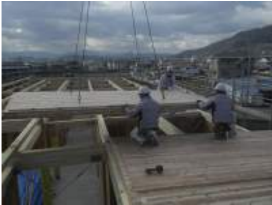
写真 25 屋根パネル建方
