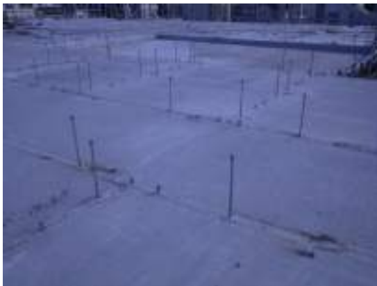
写真3 CON 打設後
