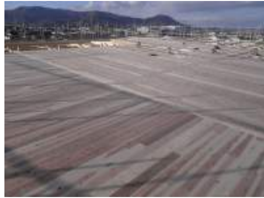
写真 26 屋根パネル建方
