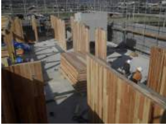
写真 17 壁パネル建方
