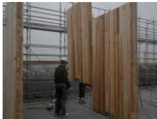
写真12 壁パネル建方
