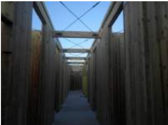
写真 21 水平ブレース
