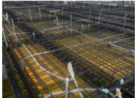
写真2 アンカーセット
