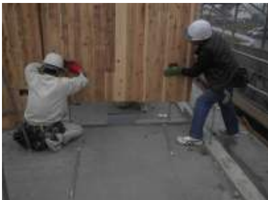
写真13 壁パネル建方
