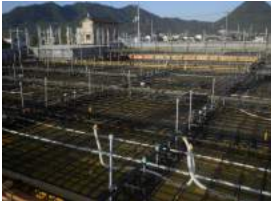
写真1 アンカーセット
