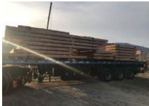
8 トレーラーで大版CLTパネル搬入 パネルは最大8段まで積んだ
