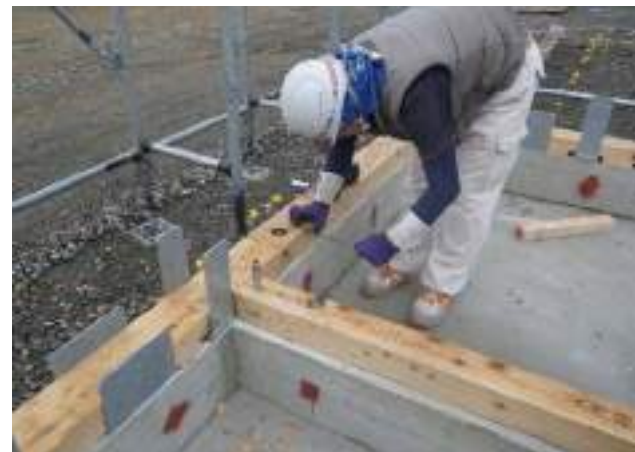
12 土台敷き 基礎上に打った墨に合わせ設置
