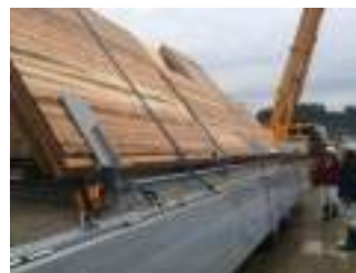
(鉄骨架台による CLT 斜め積み 2)
