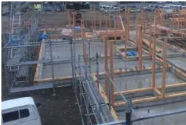
15 土台の上に柱建て 柱脚にはホゾパイプを使用
