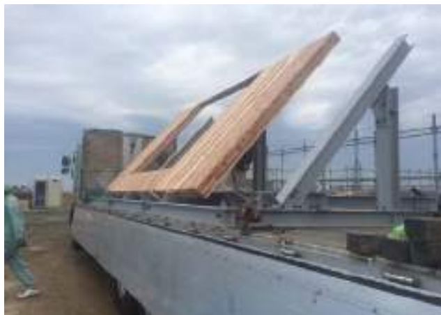
7 15tトラックでCLTパネル搬入 一部の大版パネルは鉄骨架台に斜め積とした
