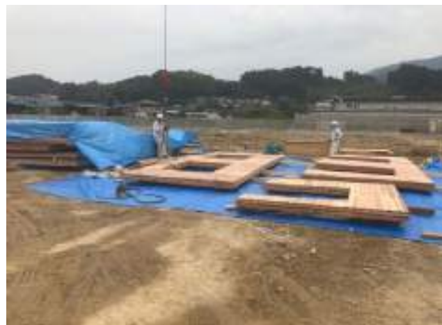
12 土台敷き 基礎上に打った墨に合わせ設置
