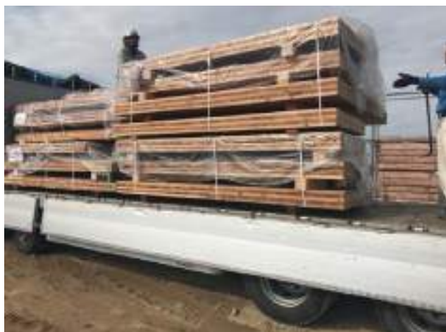
5 15tトラックでCLTパネル搬入 パネルは最大9段まで積んだ
