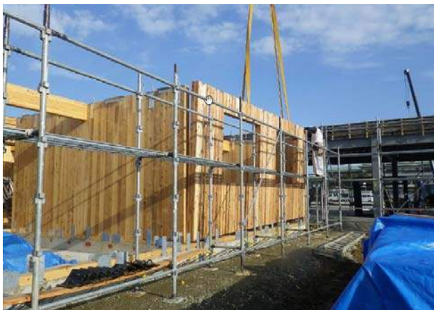
17 CLT壁パネル建て込み
