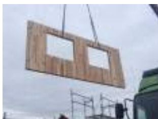
(大版パネル吊り込み状況)
