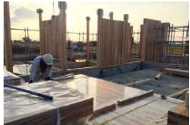
18 CLT壁パネル建て込み
