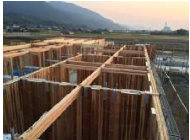
18 CLT壁パネル建て込み
