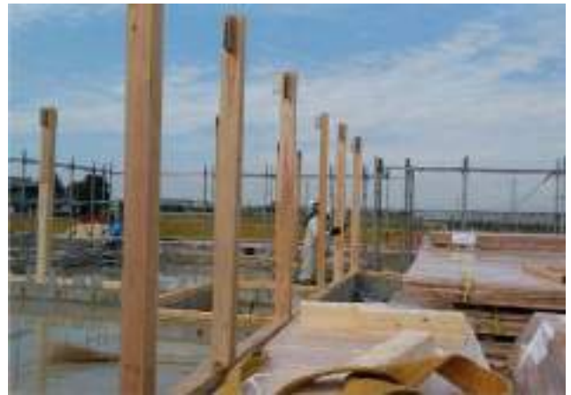
14 土台の上に柱建て 柱脚にはホゾパイプを使用
