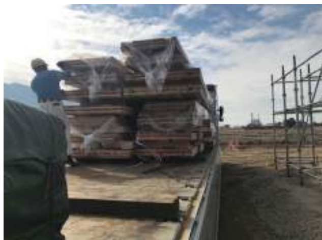
6 15tトラックでCLTパネル搬入 幅の狭いパネルは2列並べて積んだ
