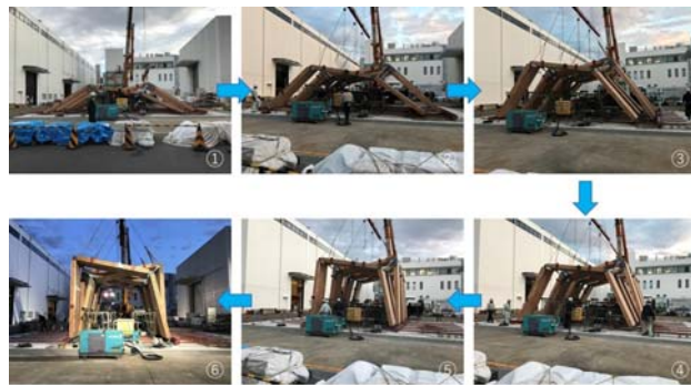
図5 CLT トラス架構のモックアップ施工プロセス
