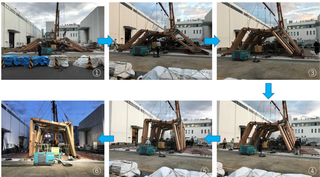
図 4.1 CLT トラス架構のモックアップ施工プロセス
