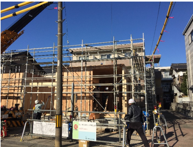
2 日目建て方完了
