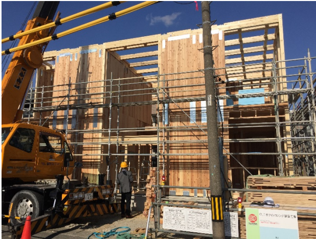
3日目建て方状況
