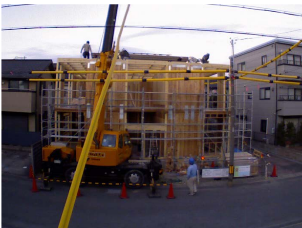
3日目建て方完了 構造材の取付はほぼ完了した。
