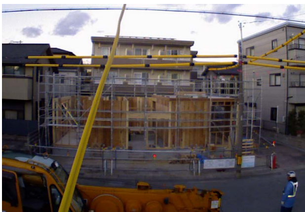
2 日目建て方完了
