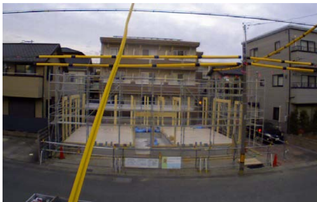
1 日目軸組部柱・梁架け
