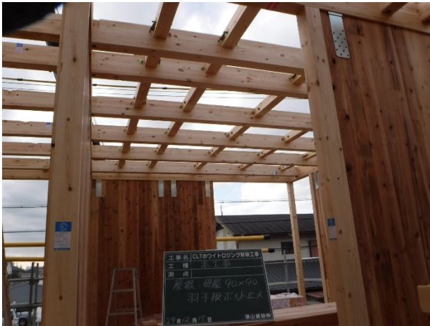
小屋組み状況 在来軸組工法とした
