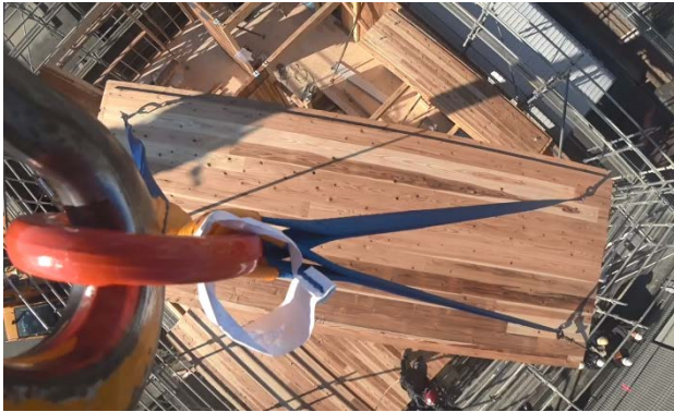
2 階床パネル設置状況
