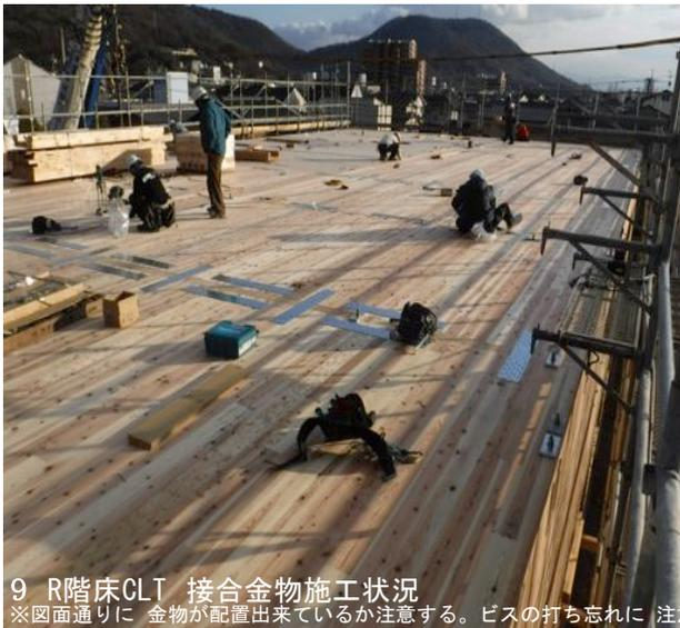
9 R階床CLT 接合金物施工状況
