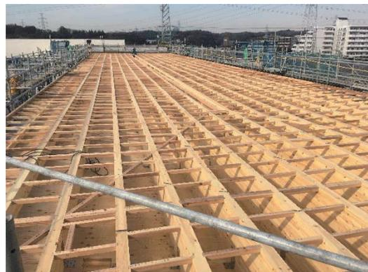
図 2-35 屋根木下地施工完了
