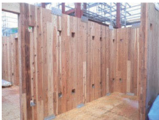
CLT パネル建込み完了
