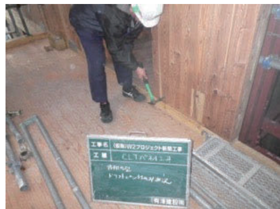
非耐力壁ドリフトピン留め状況
