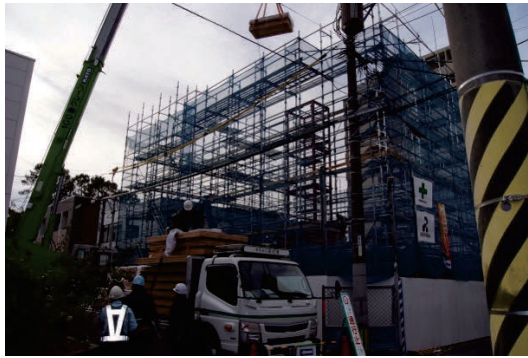
CLT 吊り込み
