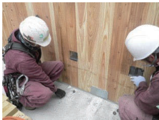
CLT パネル建込み状況
