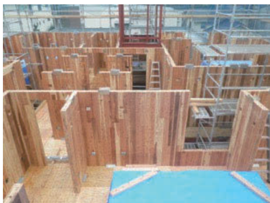
CLT パネル建込み完了
