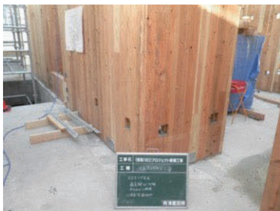
CLT パネル直交部パネリード X 留め
