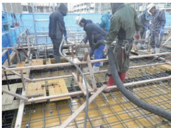
1階躯体コンクリート打設状況
