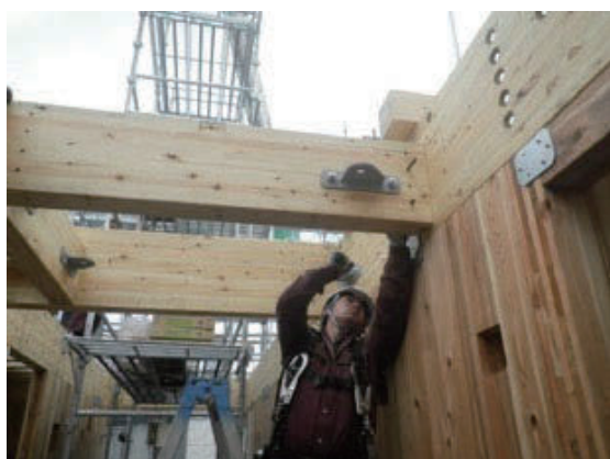
梁固定 ドリフトピン打込み
