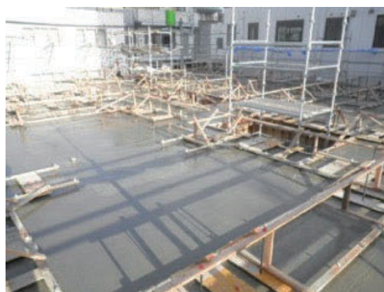
1階躯体コンクリート打設完了
