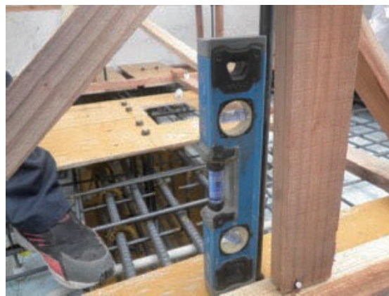
引きボルトアンカーセット確認
