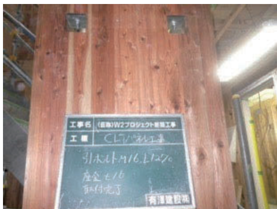
引きボルト取付け
