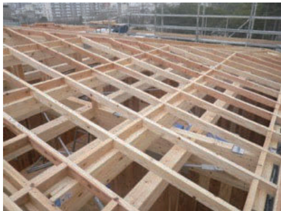
屋根垂木取付け完了
