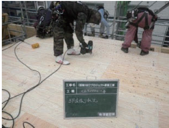
3階床張り状況
