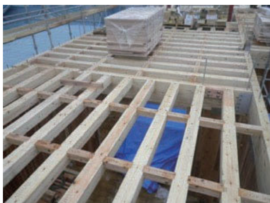
梁打込み完了
