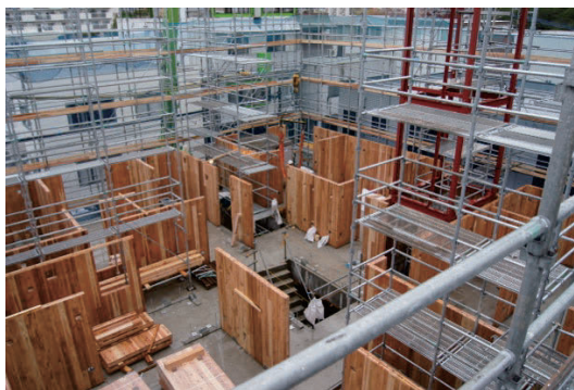
CLT パネル建て方
