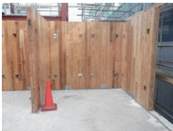
CLT パネル建込み完了
