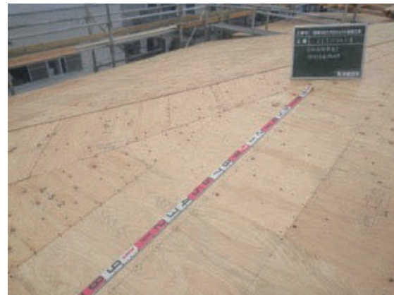
屋根合板張り状況
