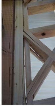
図6.2 わじのせん断破壊
