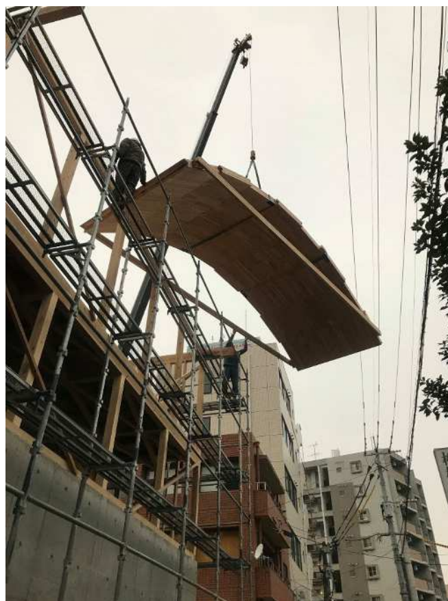
図 3. 1 建方吊り時の CLT 屋根版
