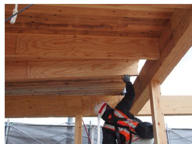
図 3.4 リブ付 CLT パネル施工
