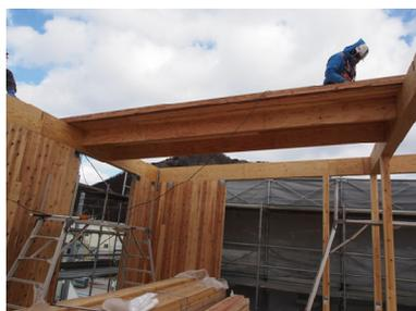
図 3.3 リブ付 CLT パネル施工
