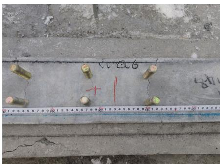
図 1.4 アンカーボルト位置の測定
