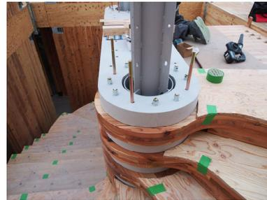
図 3.6 CLT 階段接合部
