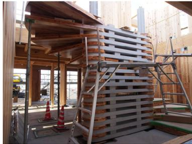
図 3.5 CLT 階段
