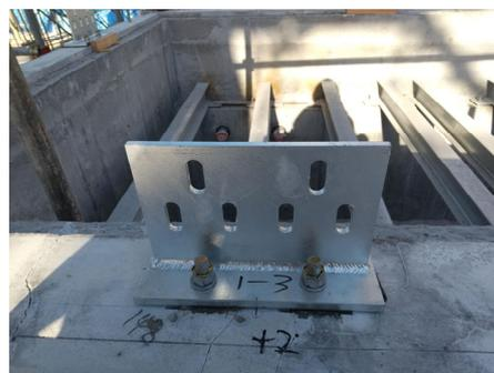
図 1.5 CLT 柱脚せん断金物
