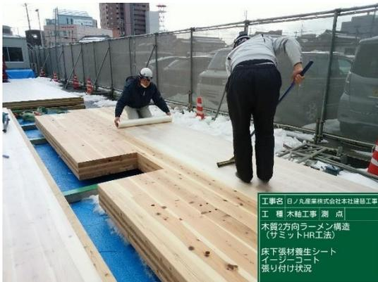
写真4 CLT設置前のシート張り状況
