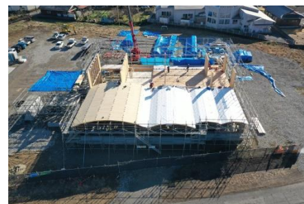
屋根 CLT 取付
