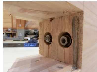
実験後のボルトの破断（解体後）
