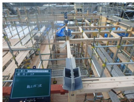
屋根 CLT 受金物取付
