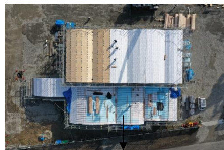
屋根 CLT 取付
