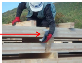
(吊込み養生金物)
