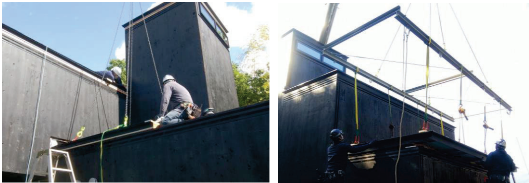
写真 4.4.2-1 屋根ユニット揚重方法の試行錯誤（左：1 屋根-2 ユニット分割案、右：1 屋根-1 ユニットとしてトラバースーを使用した案）
