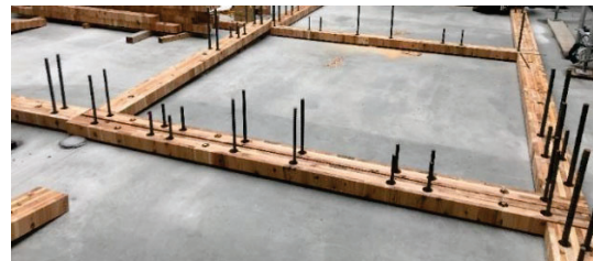
[ユニット下部施工試験時写真]
