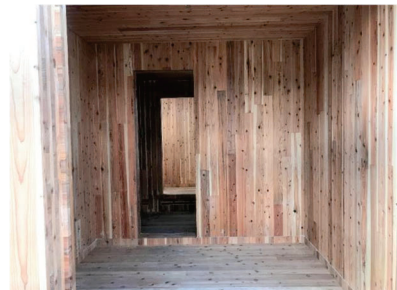
図 3.2.5 CLT ユニット(ユニット①)
