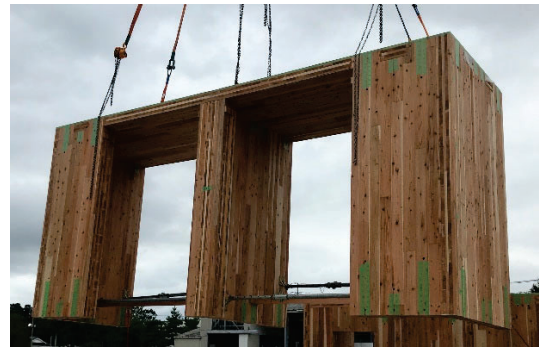
[ユニット①施工試験時写真]
