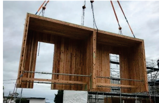
[ユニット②施工試験時写真]
