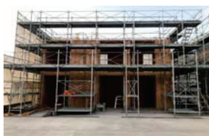
[遮音試験体施工状況]
