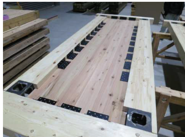
図 2 5 柱・梁が取り付けられたプレハブ化された CLT 耐力壁
