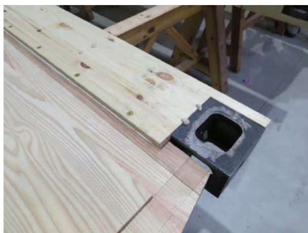
図3 柱脚接合部
