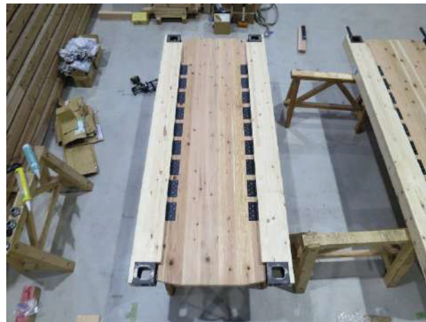
図 2 3 プレハブ化された CLT 耐力壁（組立後）
