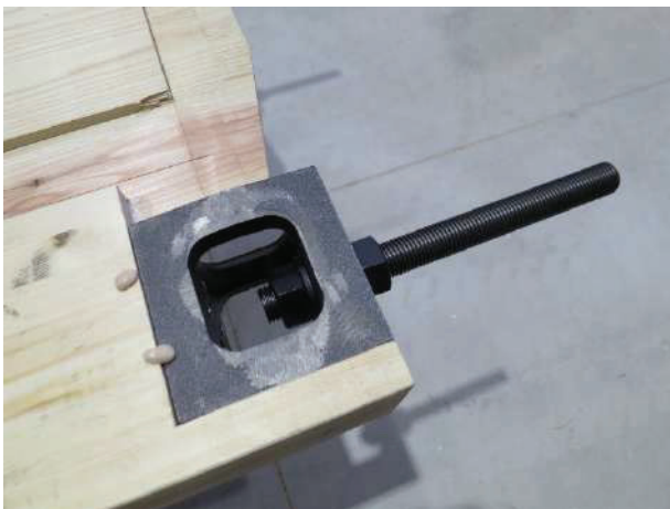
図 2 4 柱・梁取付部の様子（M30 ボルト強度区分 8.8）
