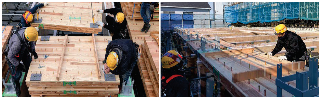
図 8-5-1-6CLT パネル支保工設置状況
