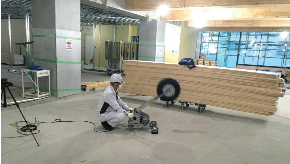
写真 8-5-3-5 バングマシン加振状況
