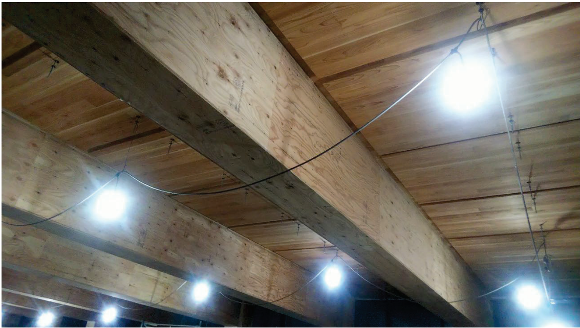
写真 8-5-3-3 CLT 床施工状況（測定経路(1),(3)～(5)音源室床）
