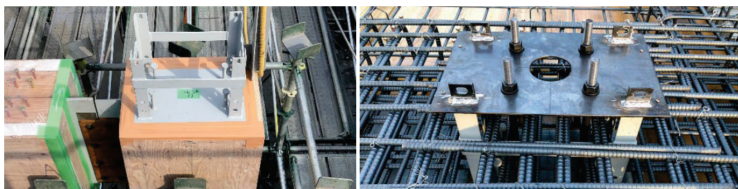
図 8-5-1-4 耐火集成材柱脚取付状況
