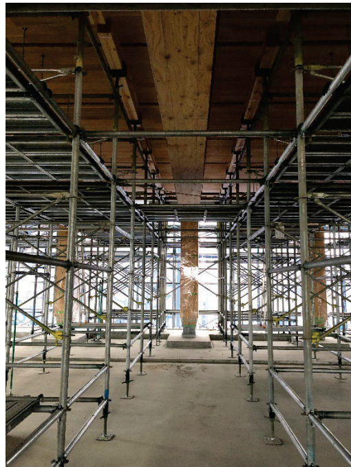
図 8-5-1-7CLT パネル養生状況・打設後の床版状況
