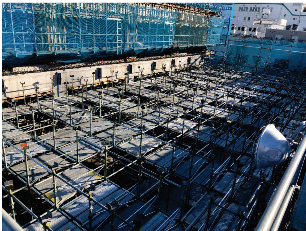
図 8-5-1-5CLT パネル支保工設置状況
