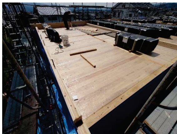
写真 4-6 2階床組み
