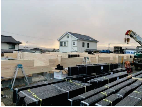
写真 4-2 搬入時の資材量（4回に分けて納品した際の1回分の量）
