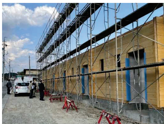
写真 4-10 2階床パネル施工完了時
