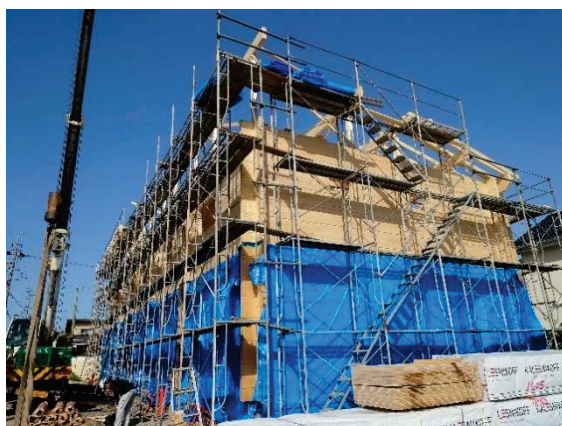
写真 4-7 CLT ログ壁の施工完了（2階まで）
