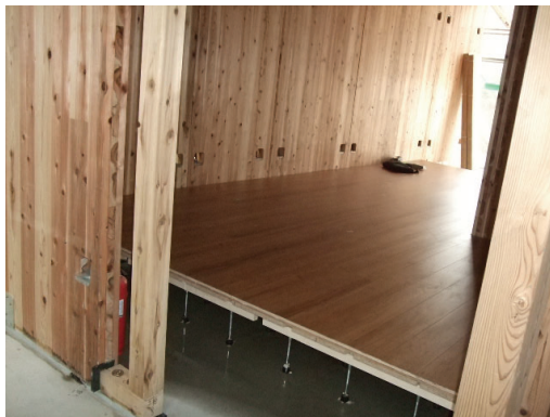
写-4 測定居室 1階の状況
