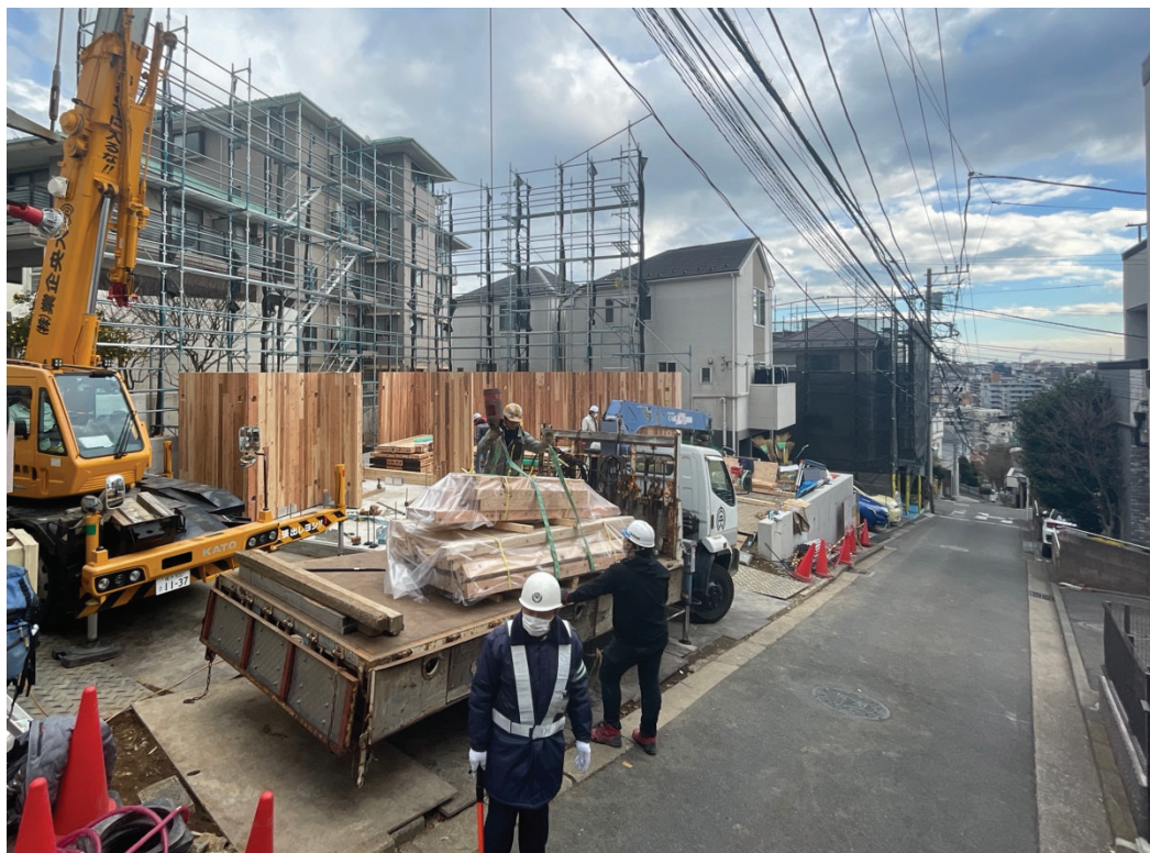
写真) 前面道路から建て方時の敷地を見た様子
