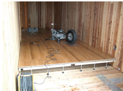
写-5 測定居室 2階の状況
