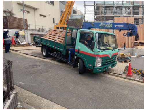
写真) 4t トラックによる敷地への搬入 横浜市西区
