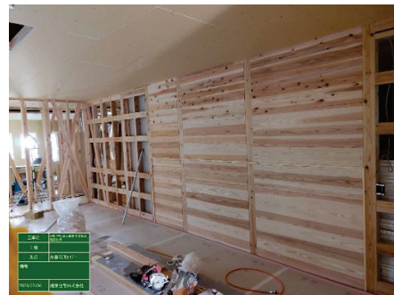
J パネル施工写真
