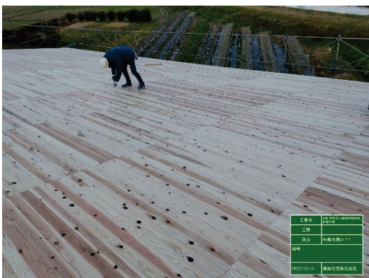
屋根 J パネル施工写真
