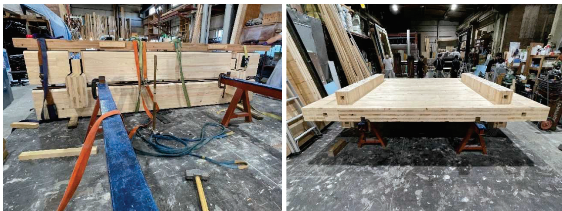
写真 3-2 防火試験体の製作
