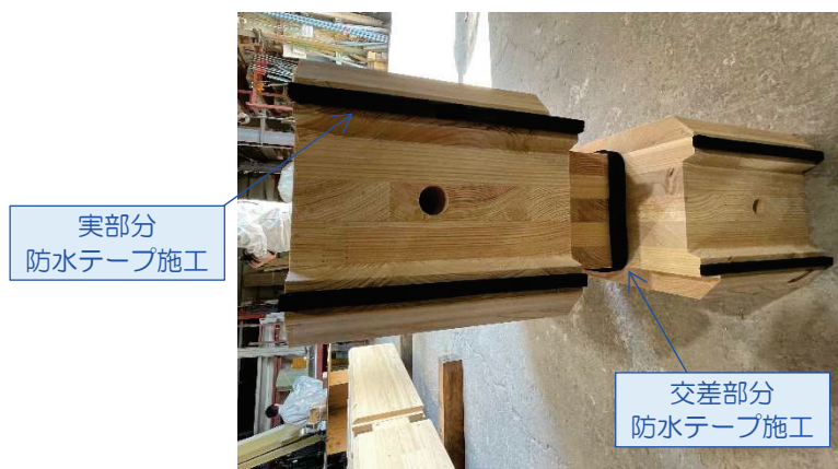
写真 3-1 防水テープ施工
