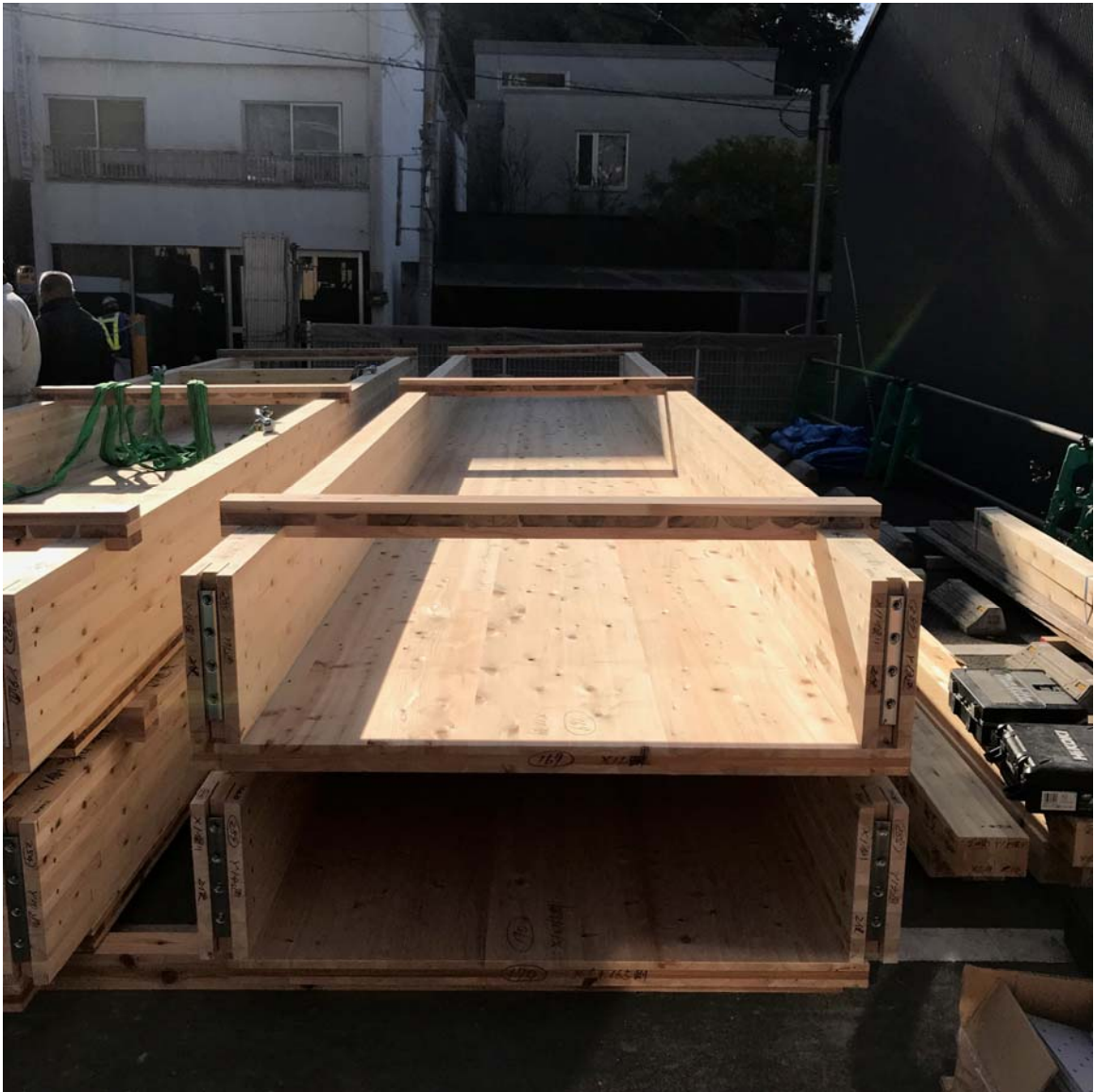
ハーフユニットを構成する桁梁の小口面にアゴ掛金物を設置。(工場施工)
