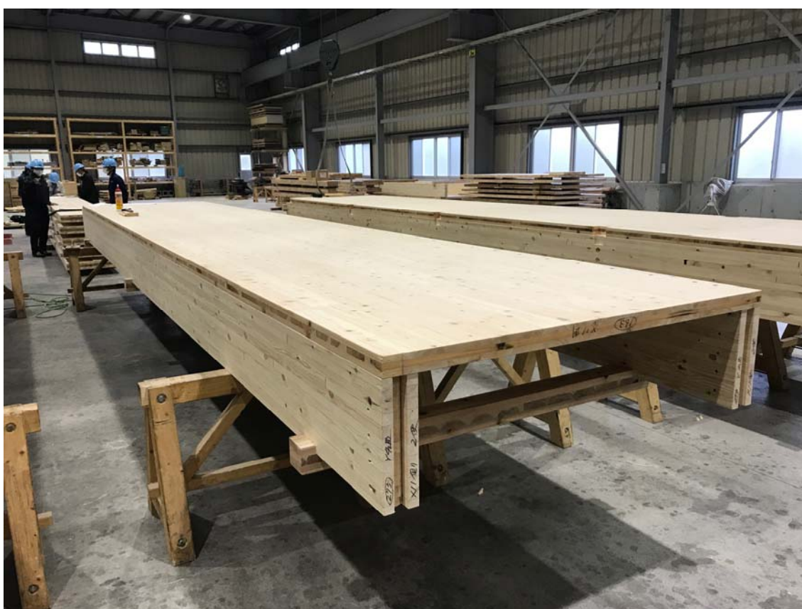
工場でのボックス型スラブの組み立風景
