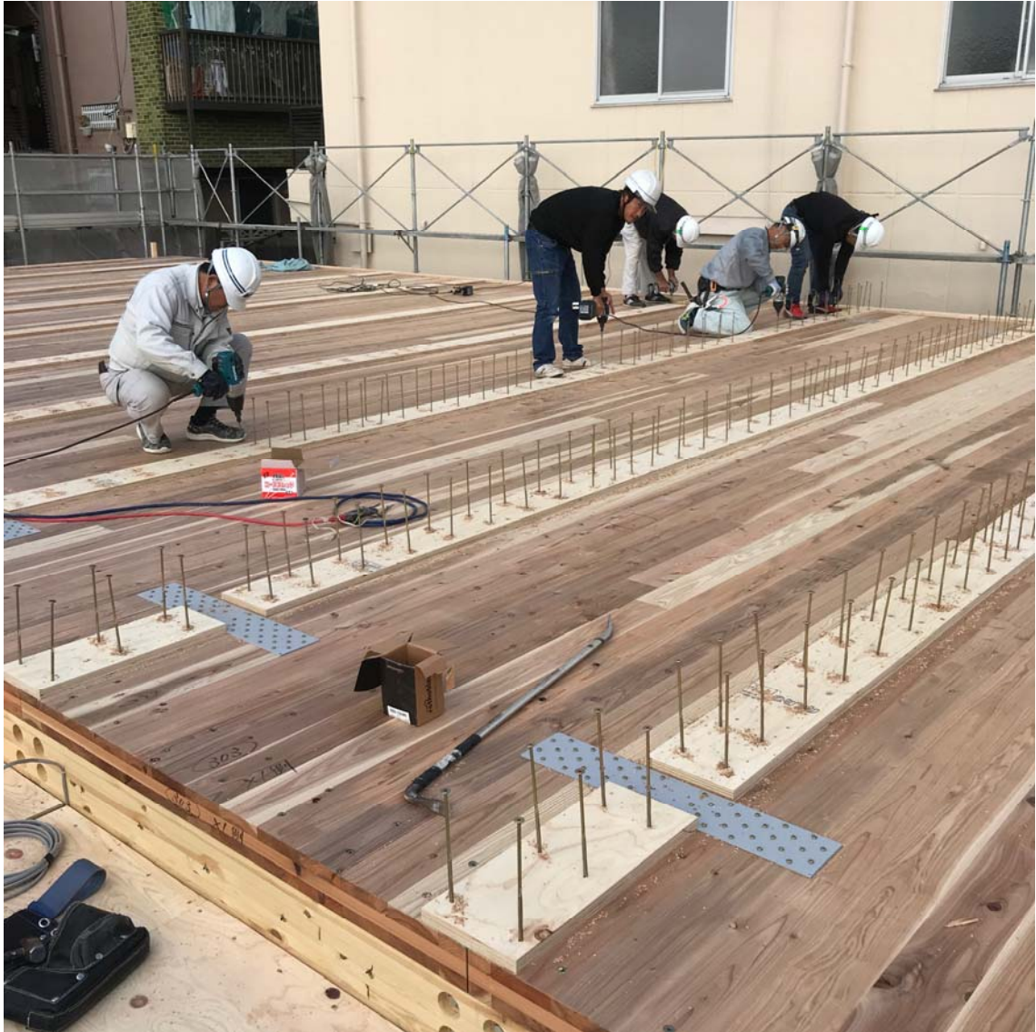
上弦材を現場で設置後、スプラインを設置し、接着剤とビスの併用で固定。 現場にてボックススラブを構築。
