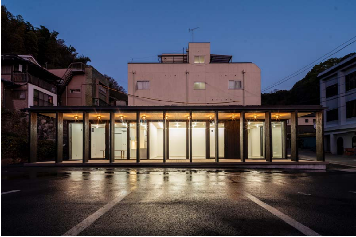
竣工写真（駐車場側より偏平柱の列柱を見る）
