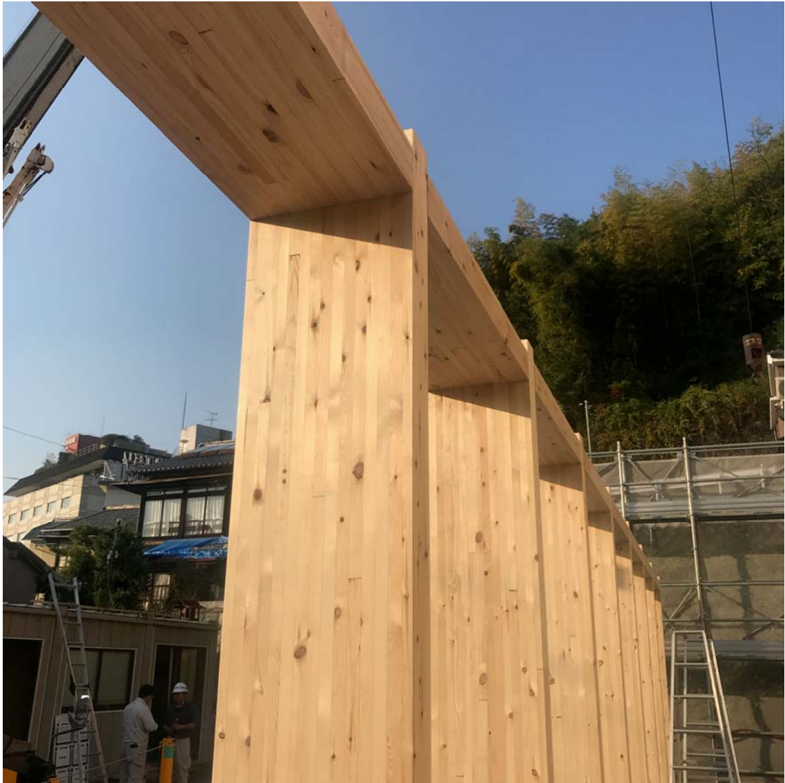
偏平柱を結ぶ偏平梁、意匠及び施工性を考慮し偏平梁を設置。
