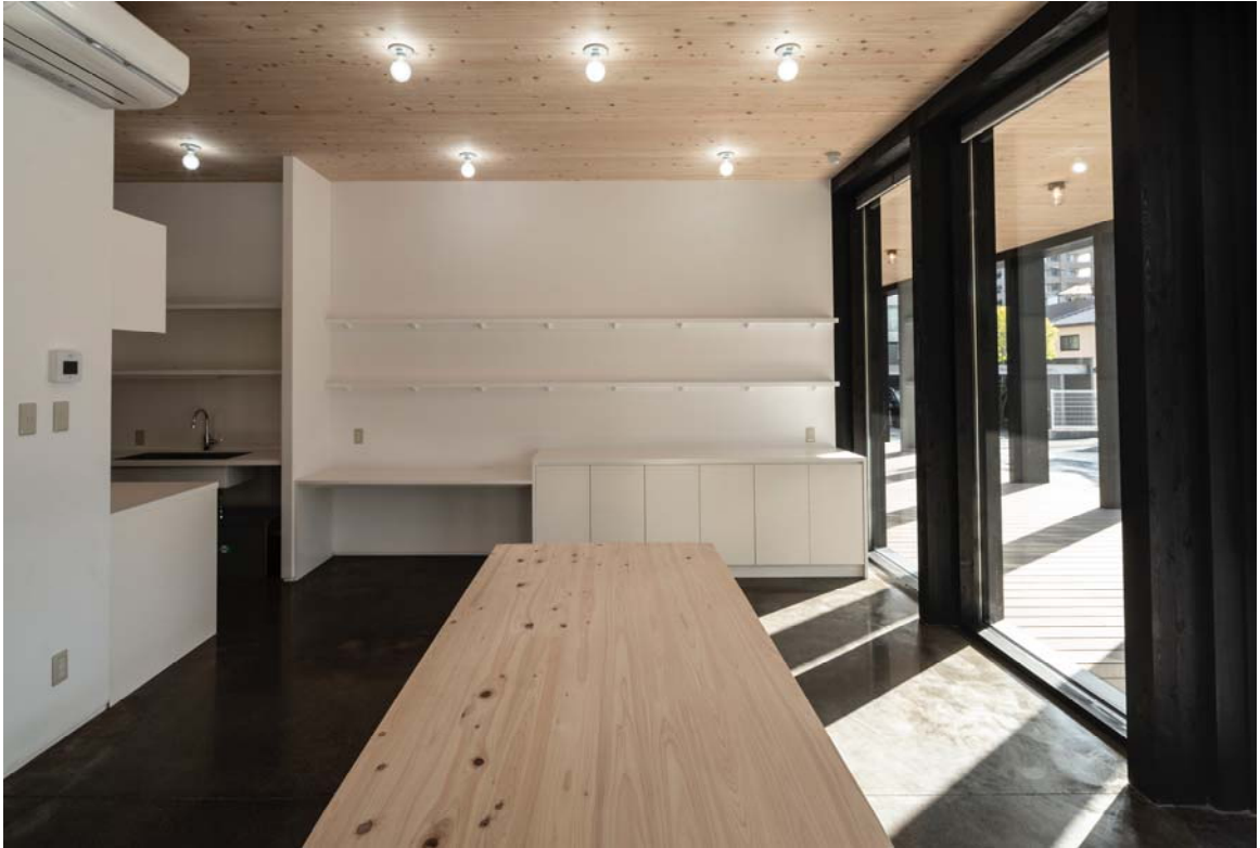
竣工写真（アトリエ内部空間、天井はボックススラブの下弦材を現し仕上げで見せている。テーブルの天板も CLT を使用。）
