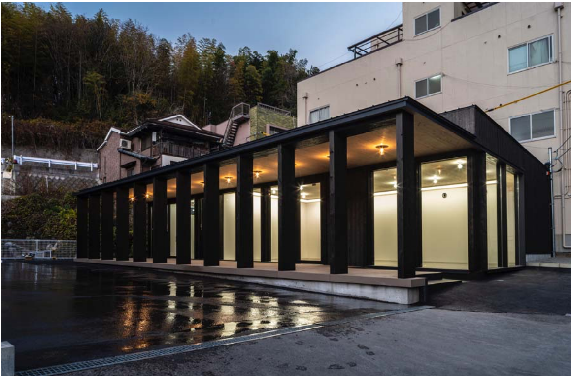
竣工写真（道路側よりギャラリー側を見る）
