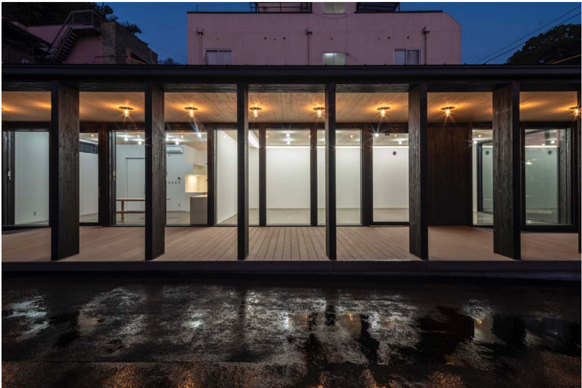
竣工写真（偏平柱越しに内部空間を見る）
