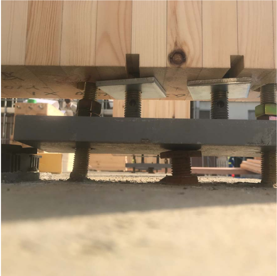
レベル調整プレートでレベル調整後、偏平柱を設置
