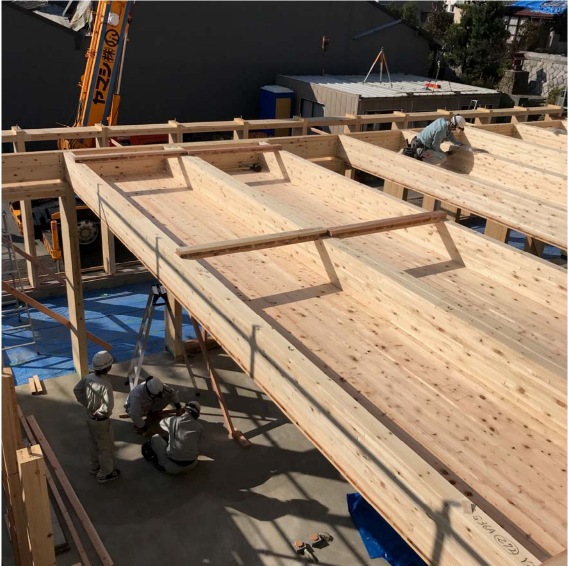
ハーフユニット設置後、桁梁どうしをビスで接合。
