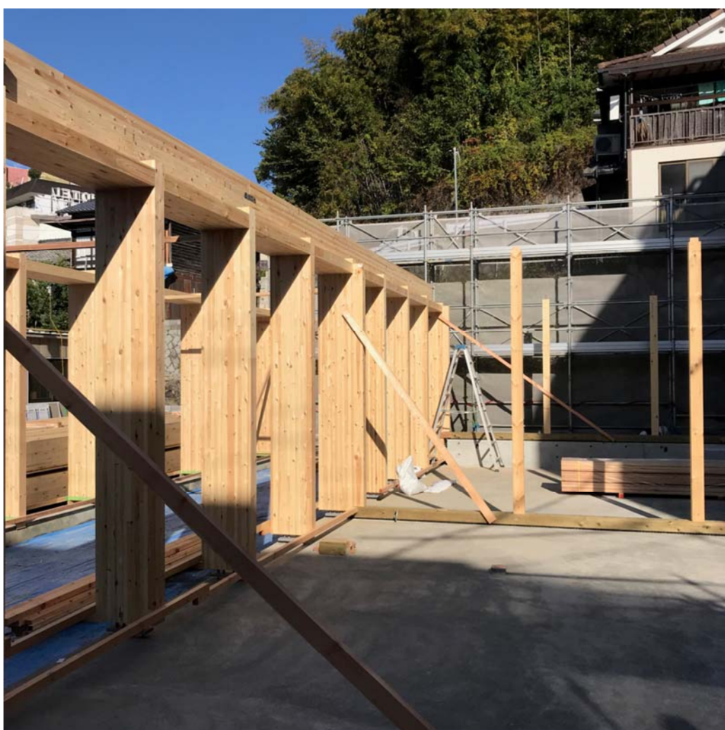
扁平柱の柱頭と大梁を GIR で緊結
