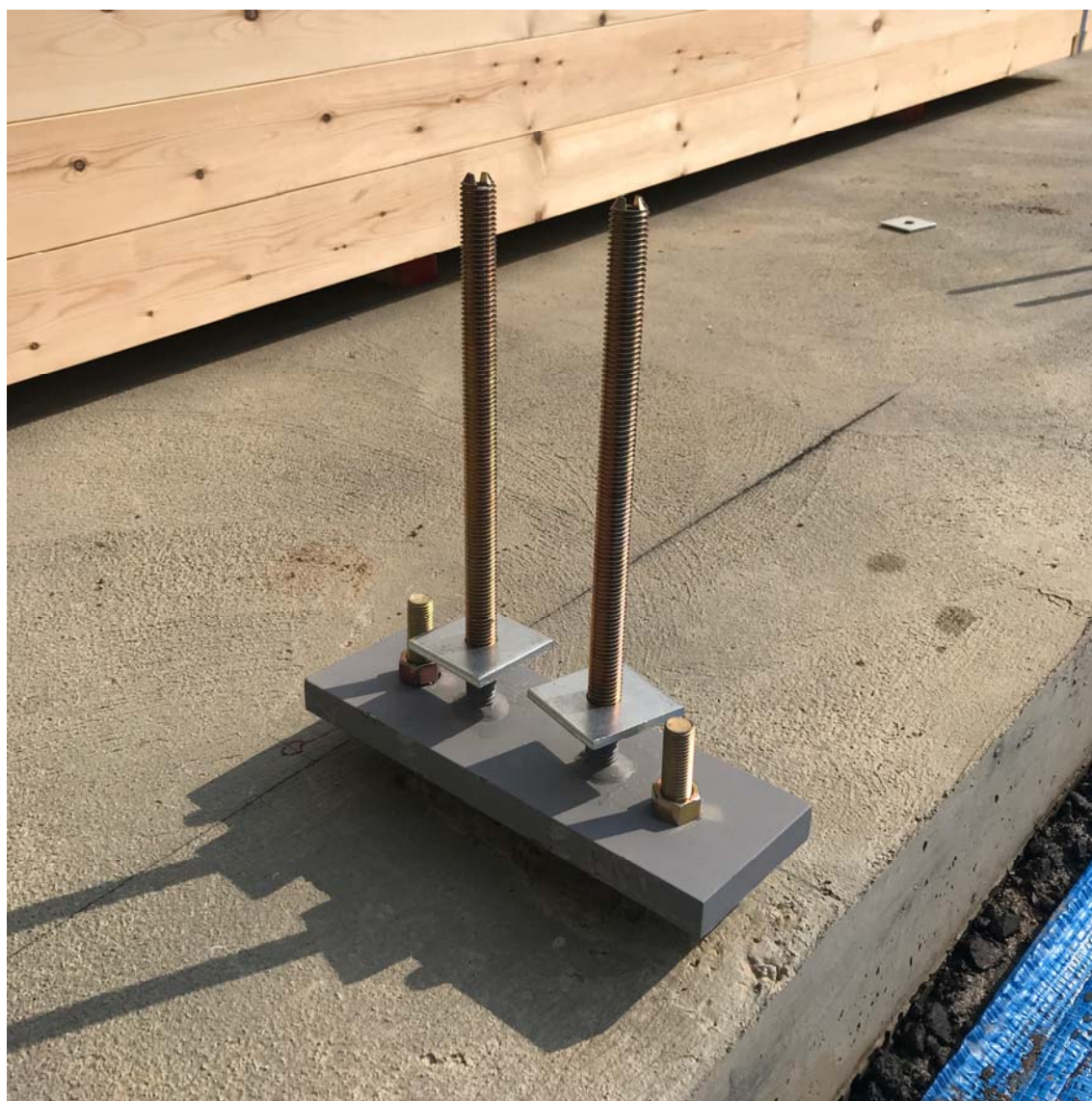
GIR レベル調整用のプレート付き金物(プレートを回転させレベル調整を行う)
