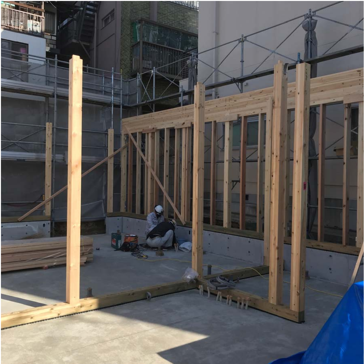
CLT ハーフユニット設置前に、耐力壁等の設置を行った。
