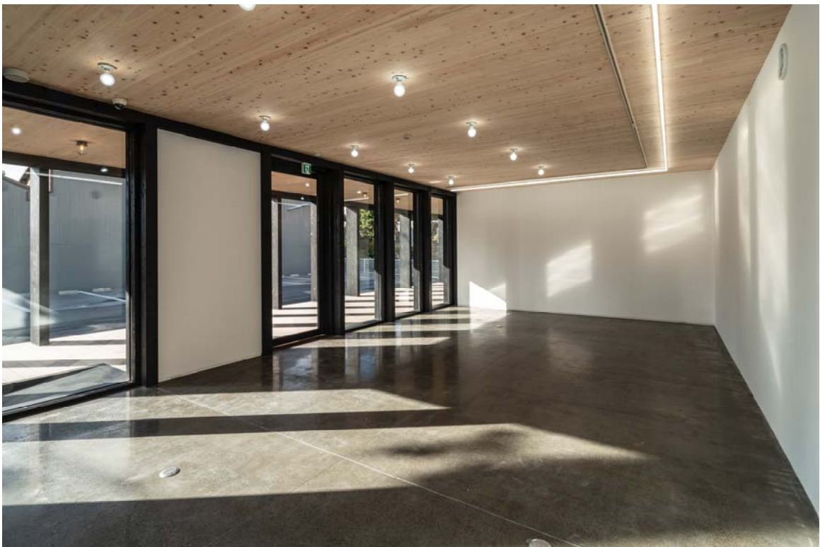
竣工写真（ショップギャラリー内部空間、天井はボックススラブの下弦材を現し仕上げで見せている。）
