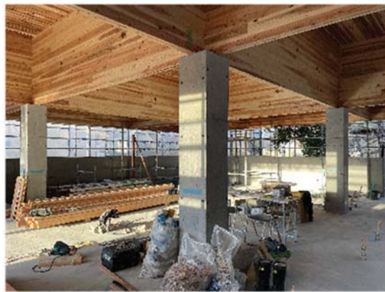
■建方、建方後 写真
