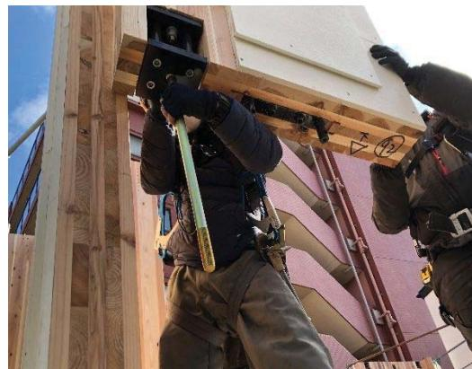
写真4 引張/圧縮用接合金物
