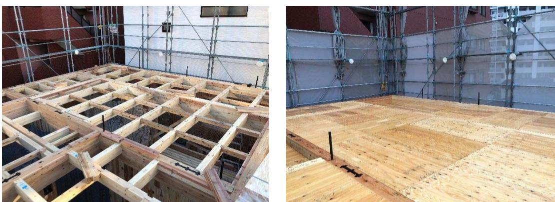
写真6 床受け材・床合板の施工
