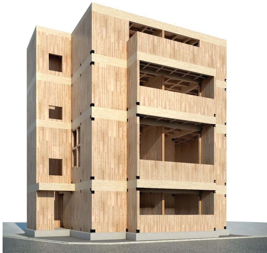
図1 CLT 軸体イメージ
