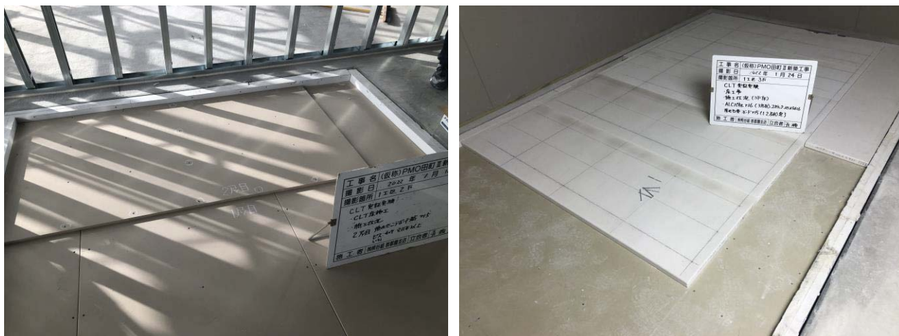
写真 2-6 CLT 板耐火被覆工事状況（上面）
