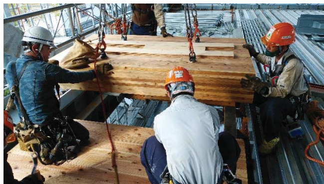
写真 2-4 CLT 板揚重状況②
