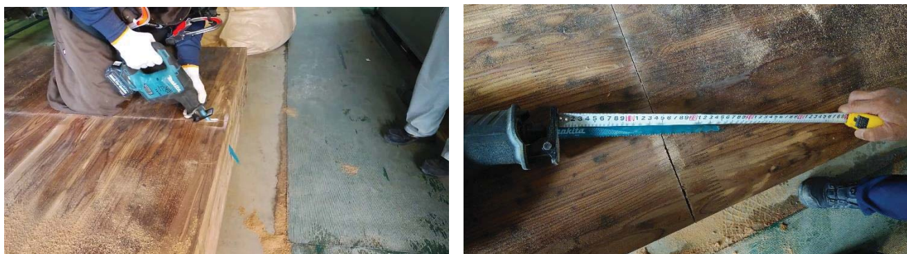
写真 2-10 セーバーソー又はレシプロソー切断状況
