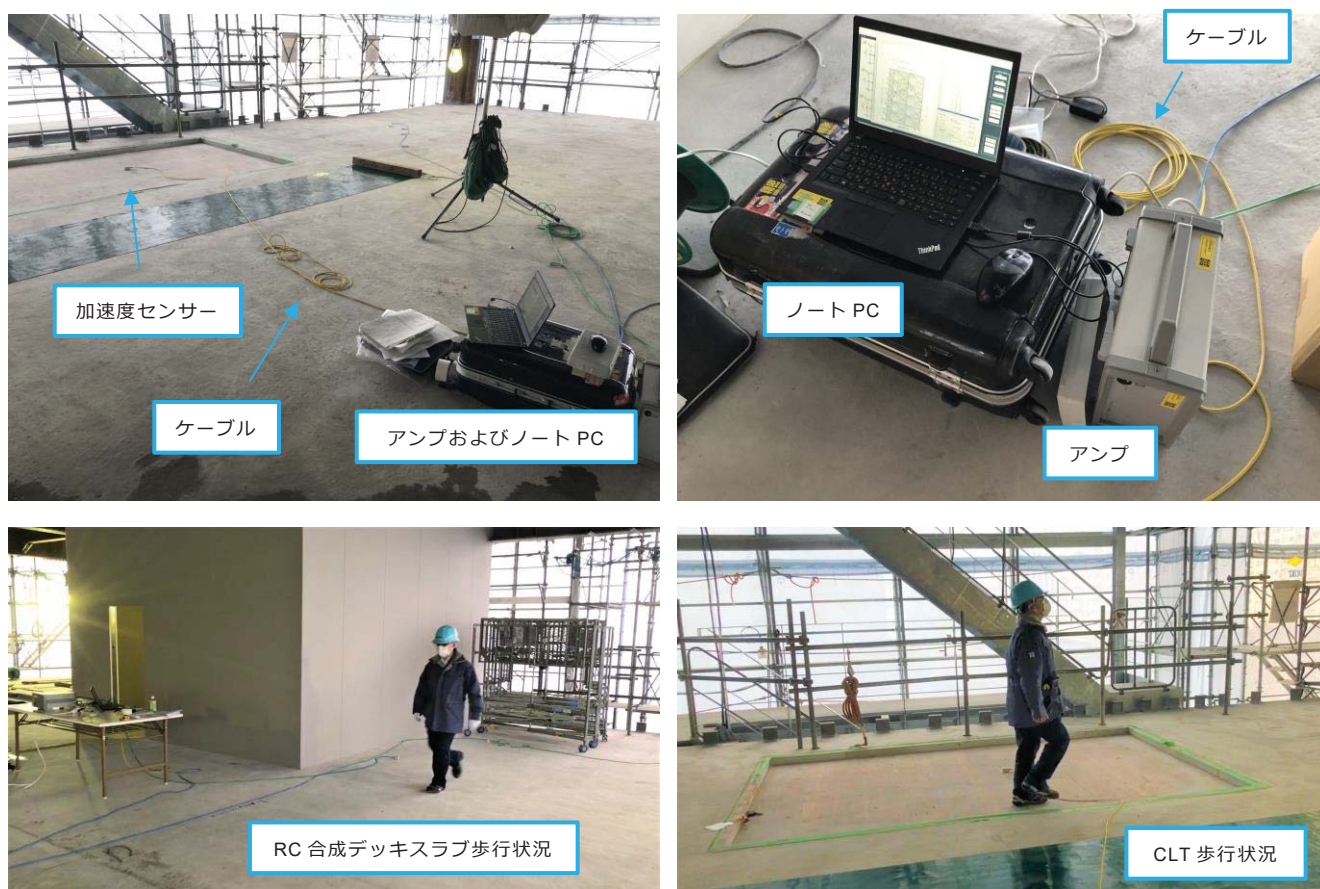
写真 3-1 床振動測定状況
