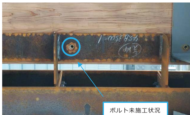
写真 2-5 CLT 板接合状況
