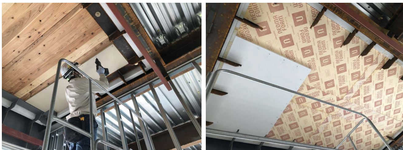
写真 2-7 CLT 板耐火被覆工事状況（下面）
