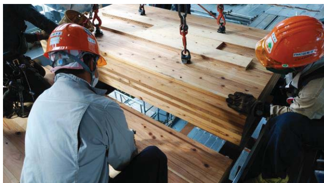
写真 2-4 CLT 板揚重状況②
