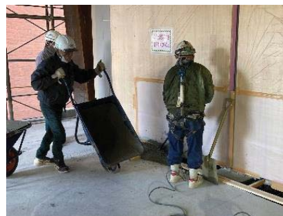
下部コンクリート打設
