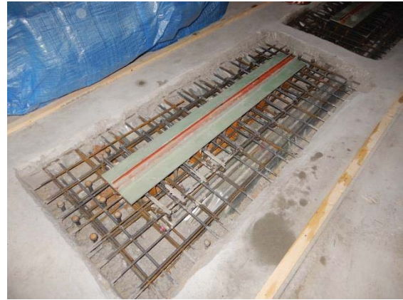
写真 4 4階 CLT 取付治具部分(コンクリート打設前)
