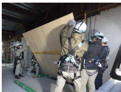
CLT（反対面）建込状況
