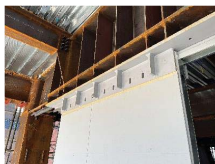
写真 2 耐震壁上部納まり
