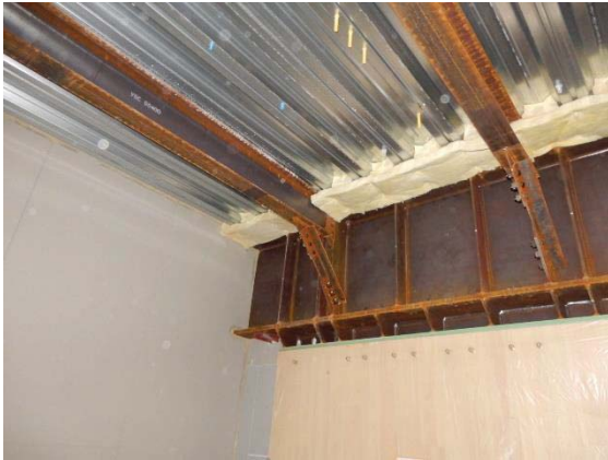
写真 3 受音室(上階スラブ方向を望む)
