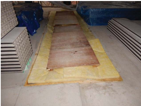
写真 5 4階 CLT 取付治具部分 (仮塞ぎ状況)
