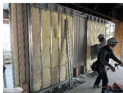
遮音壁（反対面グラスウール施工 石膏ボード貼り
