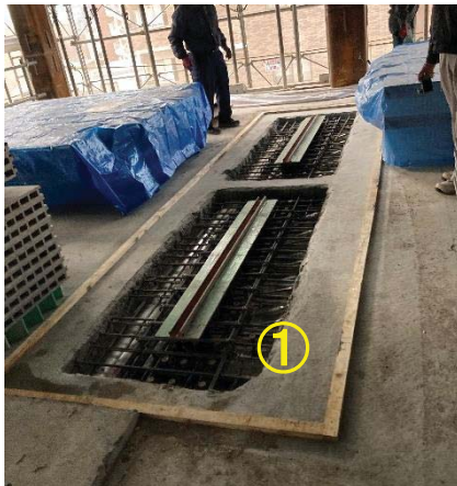
写真 1 4 階床部分 (①)
